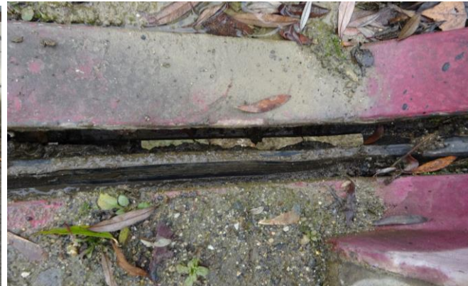
Slike 7 i 8 - detalj oštećenja na prijelaznoj napravi na S_{40} u km 25+065.35
