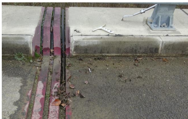
Slike 7 i 8 - detalj oštećenja na prijelaznoj napravi na S_{40} u km 25+065.35
