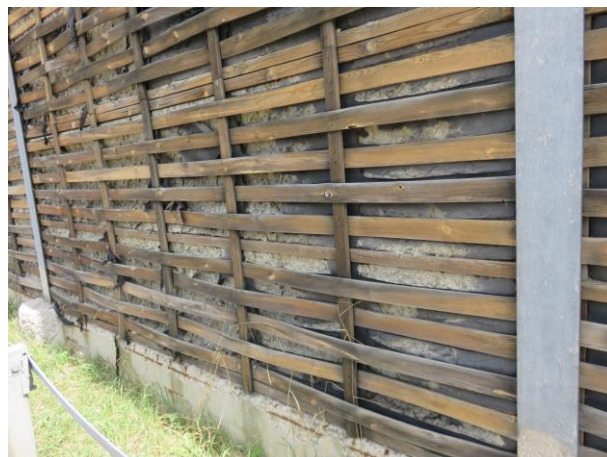
Slika Pogreška! Za dodavanje Heading 2;Heading 2 H2 tekstu koji želite da se ovdje pojavi koristite karticu Polazno.-4: Zid u km 140 – potpuno uništeni paneli u 2 polja
