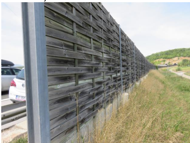
Slika Pogreška! Za dodavanje Heading 2;Heading 2 H2 tekstu koji želite da se ovdje pojavi koristite karticu Polazno.-3: Zid u km 140 – pogled na stražnju odnosno neizloženu stranu, dobro stanje
