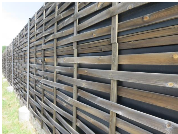
Slika Pogreška! Za dodavanje Heading 2;Heading 2 H2 tekstu koji želite da se ovdje pojavi koristite karticu Polazno.-2: Zid u km 140 – dobro stanje panela osim mjestimično puknutih letvi
