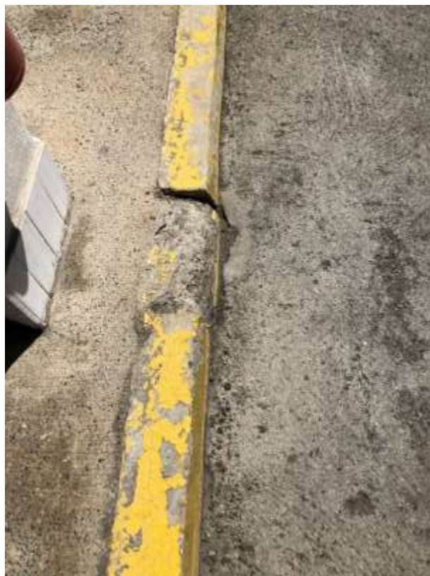
Slika 6: Uočena oštećenja rubnjaka
