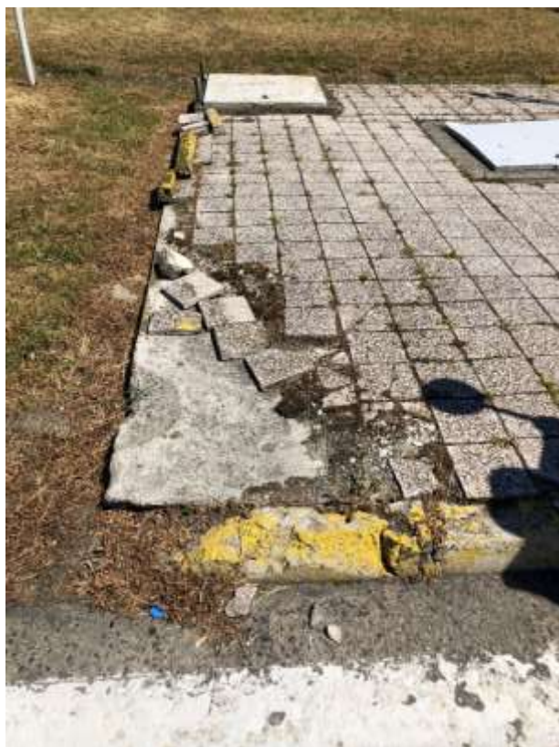
Slika 6: Uočena oštećenja rubnjaka
