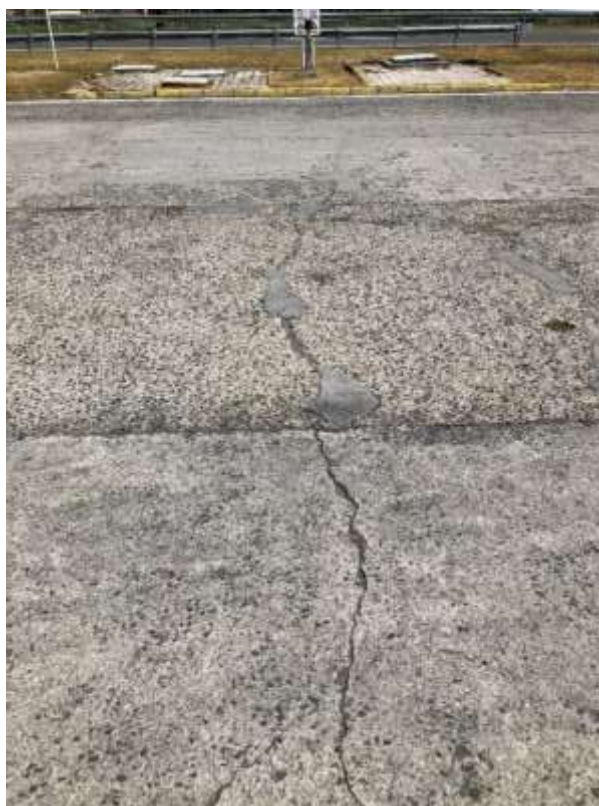
Slika 5: Uočena oštećenja betonskog kolnika uz benzinsku postaju
