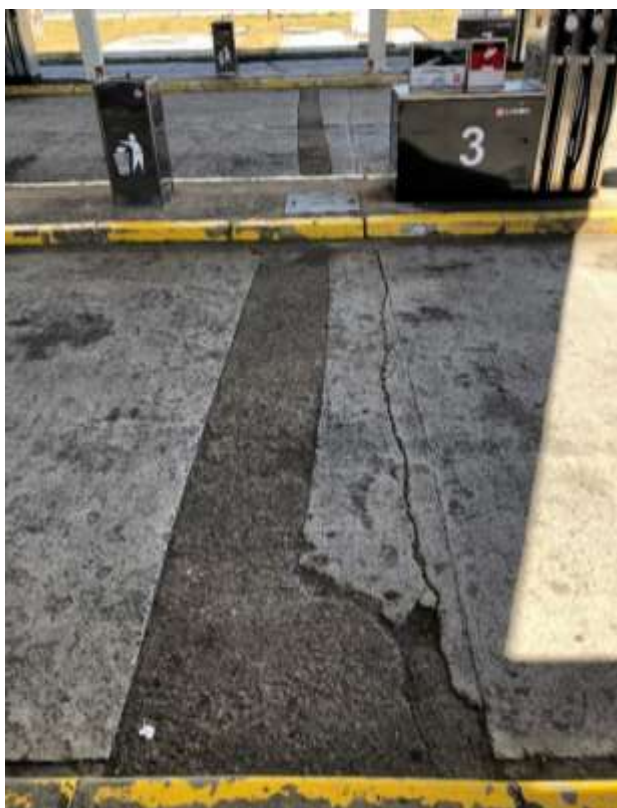
Slika 5: Uočena oštećenja betonskog kolnika uz benzinsku postaju
