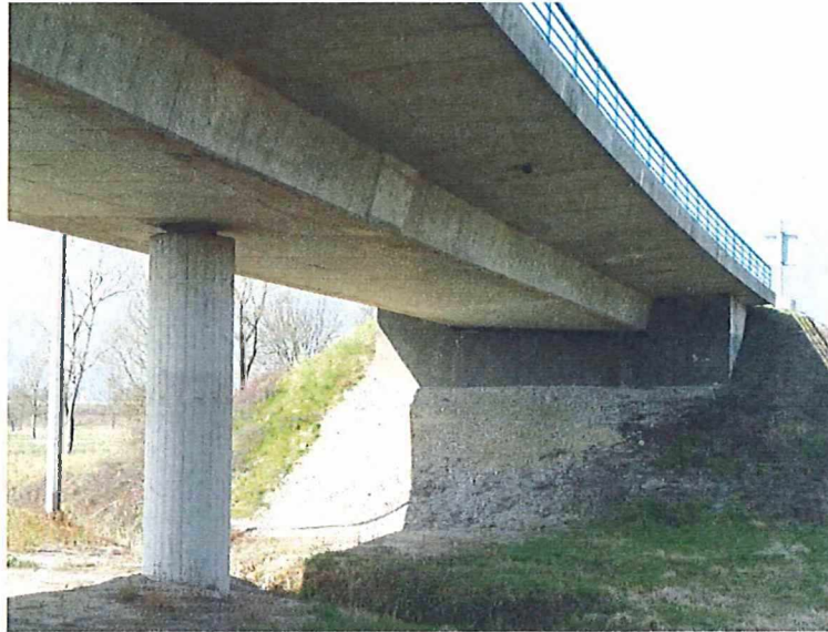
Rasponska konstrukcija i upornjak
