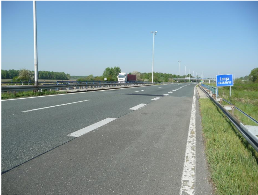
Slika 1.2-1 Pogled na most
