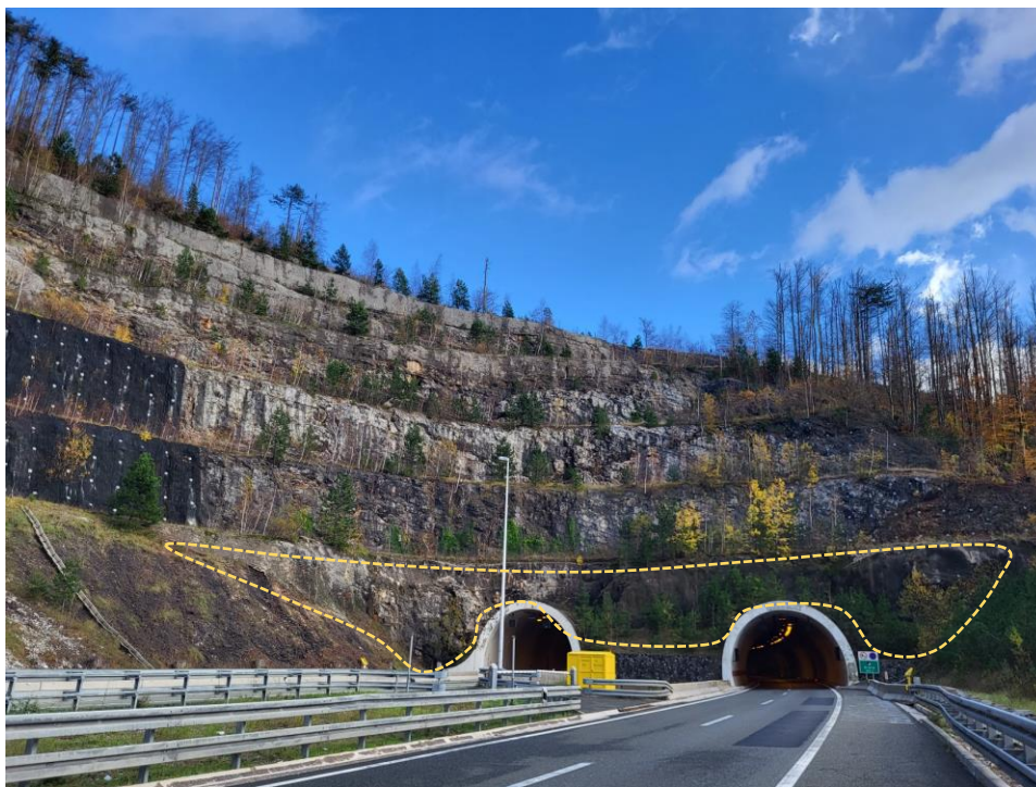
Slika 14. Prikaz prve etaže zaštite stijenskog pokosa iznad ulaznog portala tunela „Vrata“
