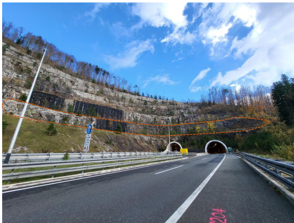
Slika 15. Prikaz druge etaže zaštite stijenskog pokosa iznad ulaznog portala tunela „Vrata“
