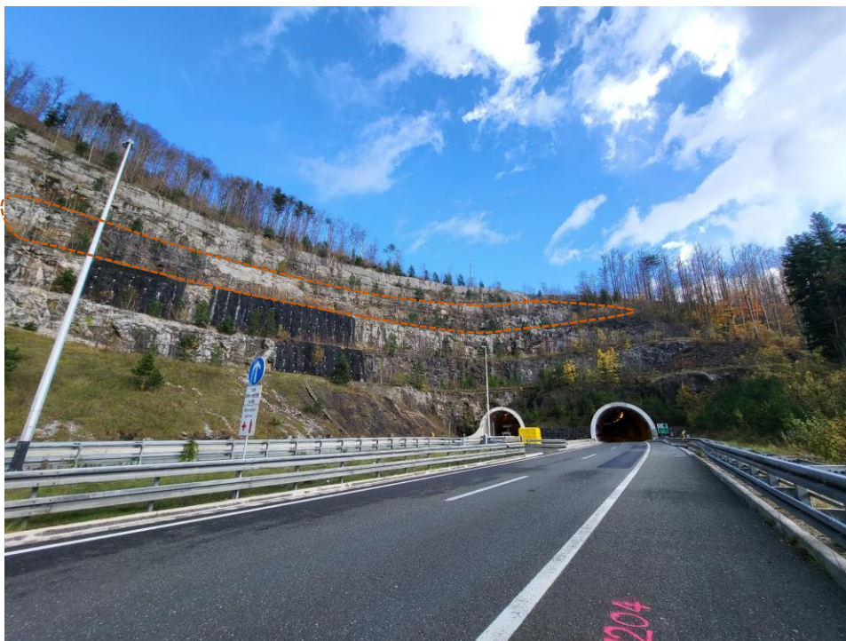
Slika 17. Prikaz četvrte etaže zaštite stijenskog pokosa
