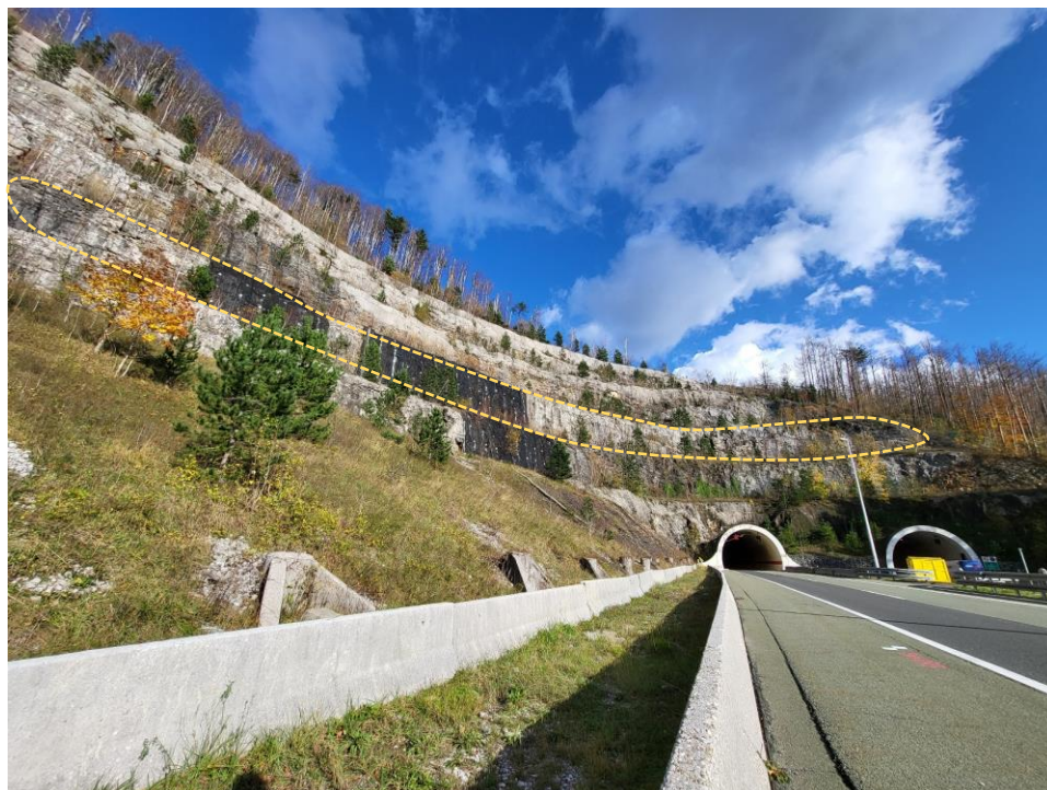
Slika 16. Prikaz treće etaže zaštite stijenskog pokosa
