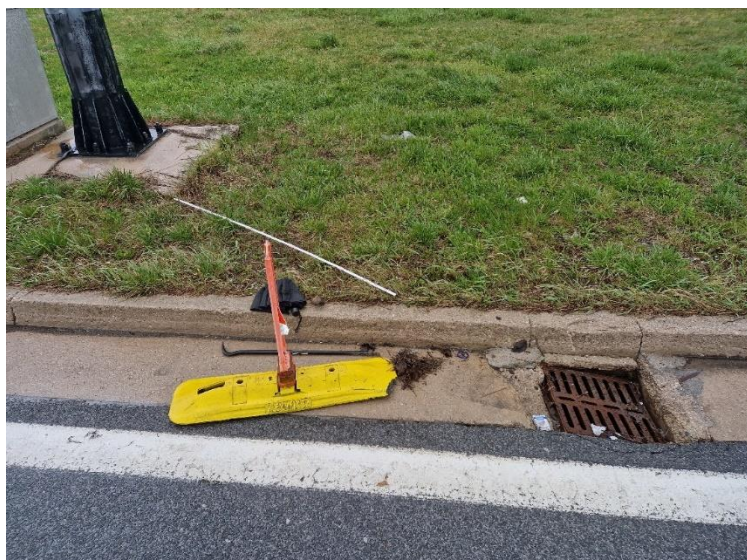
Slika 3 Oštećeni slivnik
