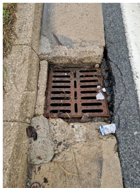
Slika 4 Oštećeni slivnik
