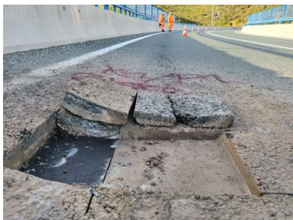
Fotografija 1: Uzorkovanje kolničke konstrukcije na nadvožnjaku čvora Bisko
