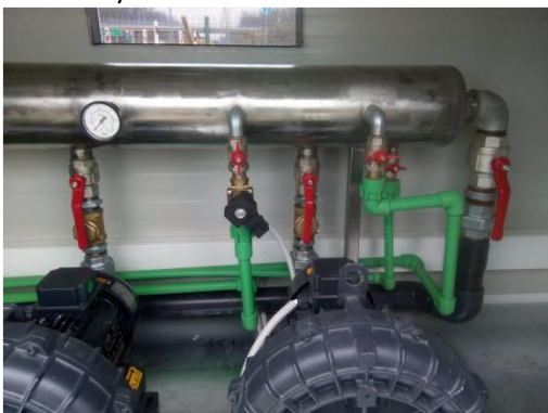
Slika 2.1./5. Elektromagnetski ventil
