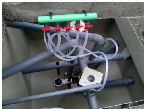
Slika 2.1./4. Sekundarni taložnik
