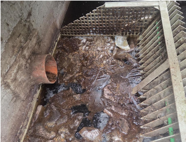
Slika 3.4. Ulazna cijev u UPOV s pripadajućom grubom rešetkom
