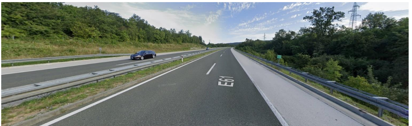
Slika 3. Završetak zahvata _km 10+000 ( gledano u smjeru NP Rupa )
