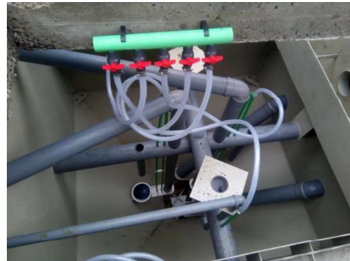
Slika 2.1./4. Sekundarni taložnik
