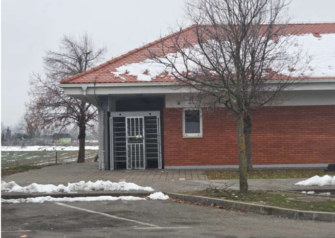
Slika 3.2. Objekt sanitarnog čvora na odmorištu Bošnjaci smjer Lipovac (nije u funkciji)
