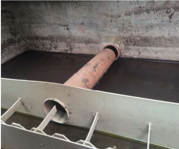
Slika 3.8. Ispust pročišćene vode
