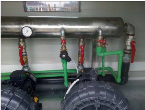
Slika 2.1./5. Elektromagnetski ventil
