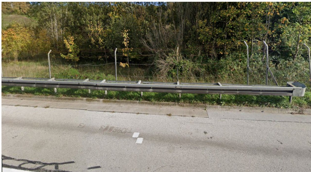
Slika 2. Prikaz postojećih odbojnih ograda uz rubove kolnika
