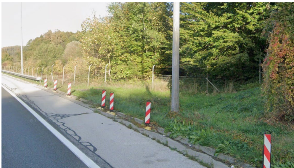
Slika 4. Prikaz nezaštićenog stupa rasvjete
