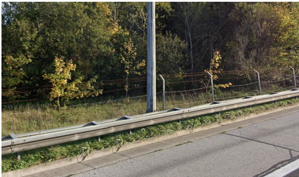
Slika 3. Prikaz postojećih odbojnih ograda uz stupove rasvjete ruba kolnika
