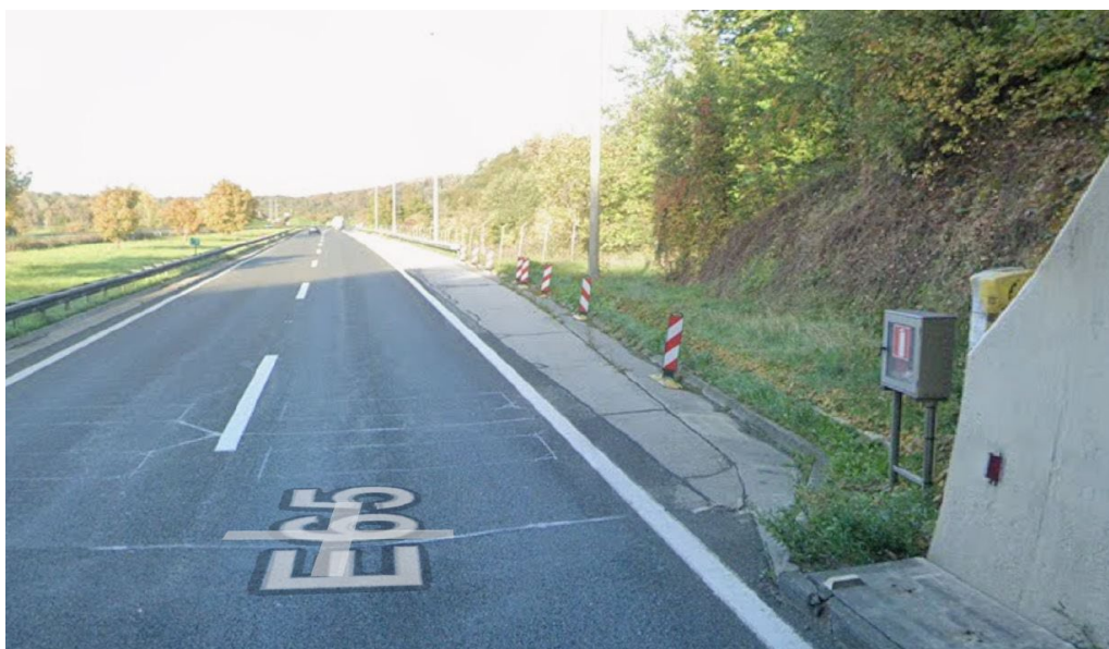
Slika 1. Izlaz iz tunela Sveti Marko u smjeru Zagreba
