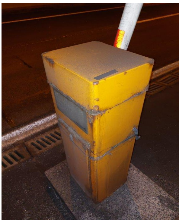
Slika 1. Postojeće električna pokretna brklja model BL 32. proizvođača Automatic Systems, tunel Mala Kapela (A1)
