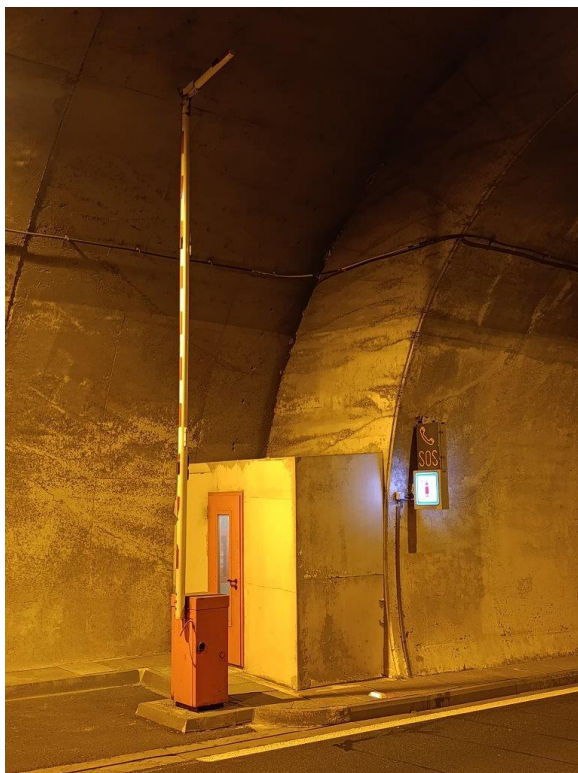
Slika 1. Postojeće električna pokretna brklja model BL 32. proizvođača Automatic Systems, tunel Mala Kapela (A1)
