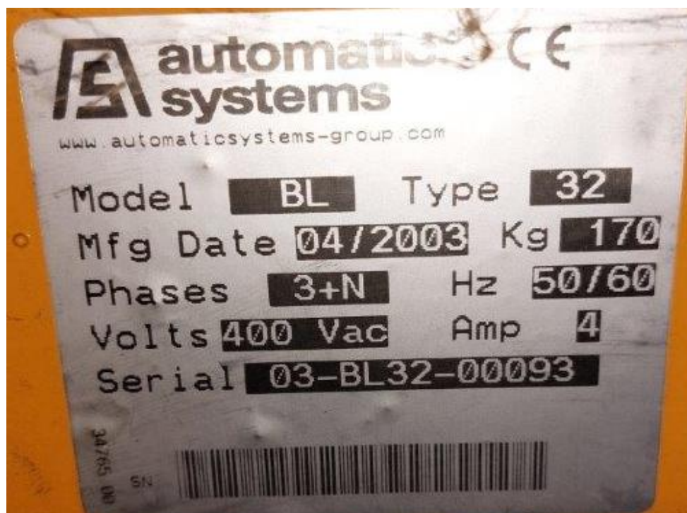
Slika 3. Osnovne karakteristike postojeće električne pokretne brklje model BL 32 proizvođača Automatic Systems, tunel Mala Kapela (A1)
