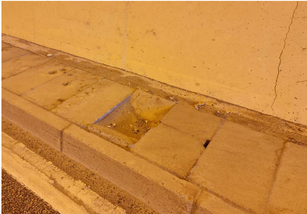
Slika 7: Kampada 181 - RUNIRANJE AB PLOČE HODNIKA
