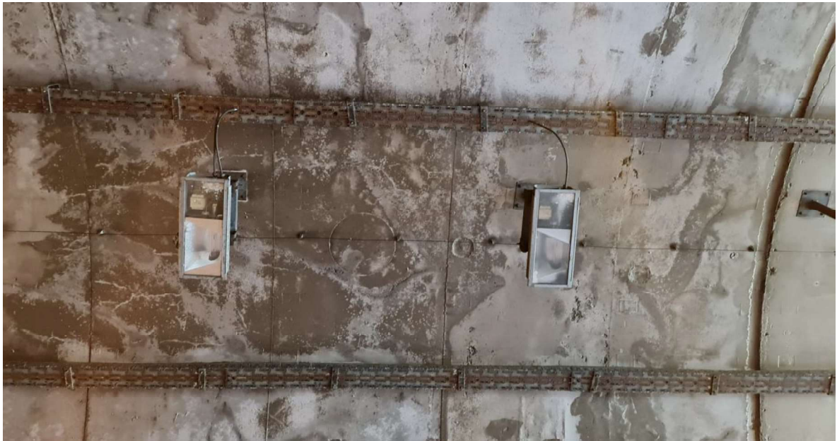
Slika 32: Kampada 3 - SEGREGACIJA I LJUŠTENJE PREMAZA
