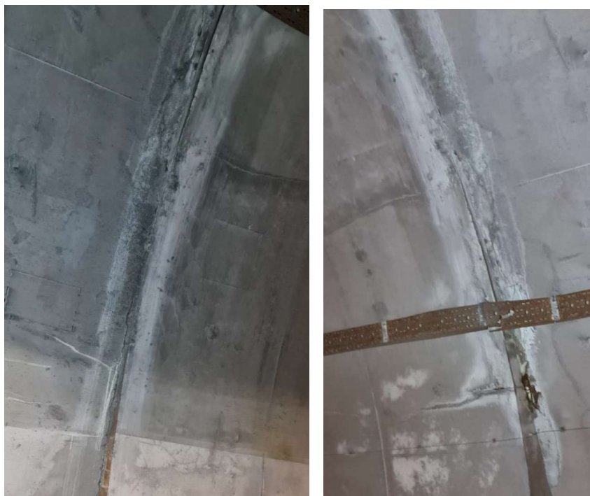
Slika 23: Kampada 90 - LJUŠTENJE I IZLUŽIVANJE SPOJNICE
