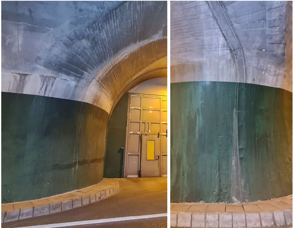
Slika 20: Kampada 91 - RADIJALNE PUKOTINE SA IZLUŽIVANJEM
