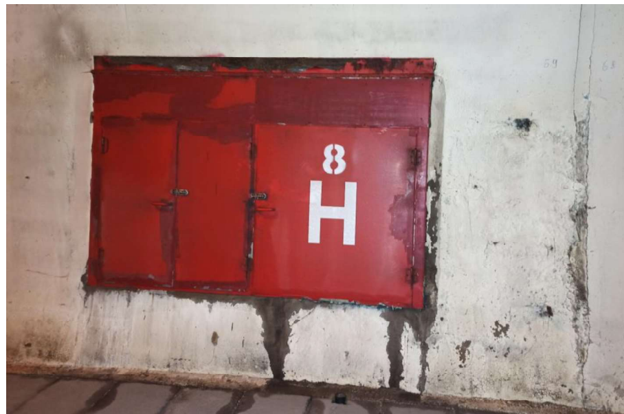
Slika 30: Kampada 69 - LJUŠTENJE PREMAZA I VLAŽENJE
