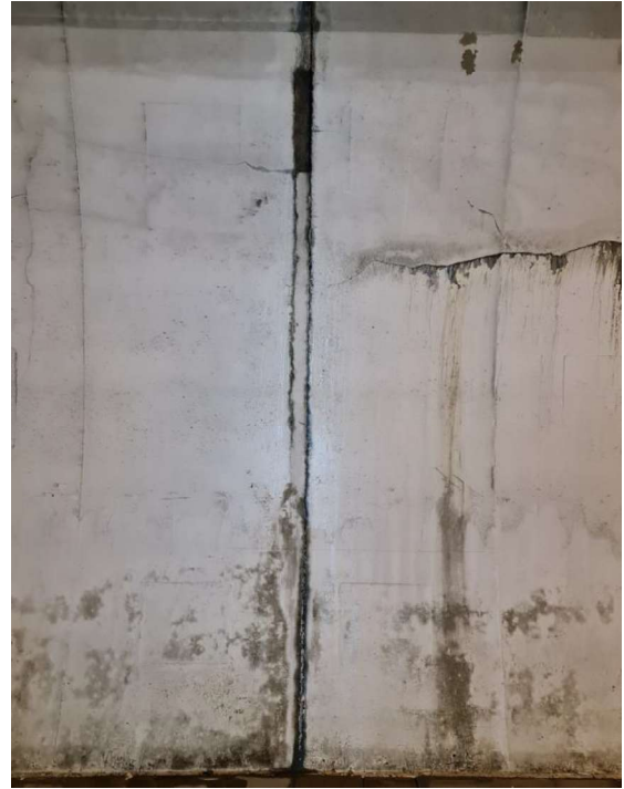
Slika 63: Kampada 188 - 189 - PUKOTINA, IZLUŽIVANJE I ODLAMANJE BETONA
