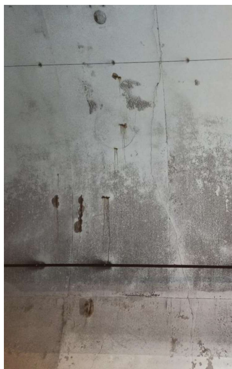
Slika 24: Kampada 57 - IZLOŽENA ARMATURA, KOROZIJA, PUKOTINE I VLAŽENJE
