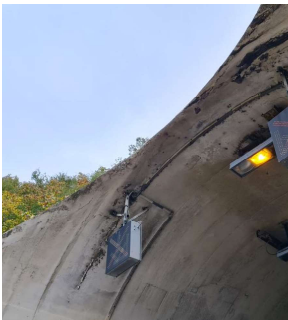
Slika 66: Izlazni portal - PUKOTINE I LJUŠTENJE BETONA I PREMAZA
