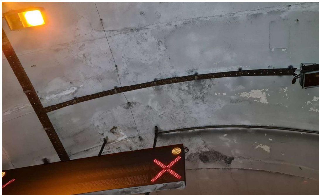
Slika 40: Kampada 98 - VLAŽENJE, IZLUŽIVANJE I LJUŠTENJE PREMAZA
