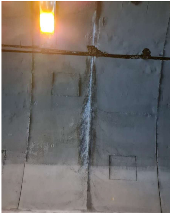
Slika 63: Kampada 188 - 189 - PUKOTINA, IZLUŽIVANJE I ODLAMANJE BETONA
