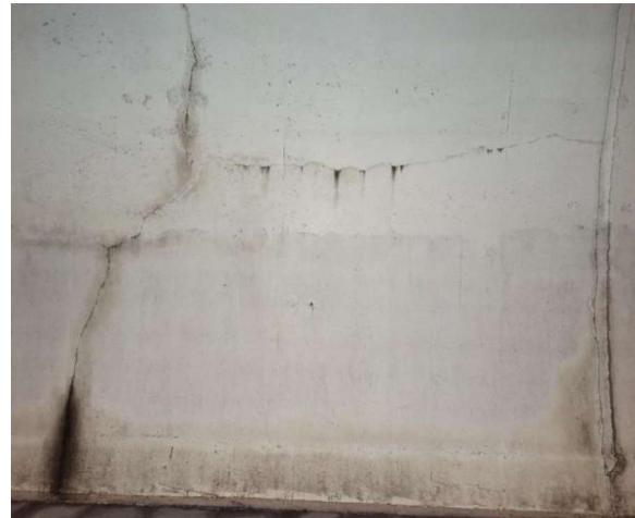
Slika 26: Kampada 63 - PUKOTINE I IZLUŽIVANJE
