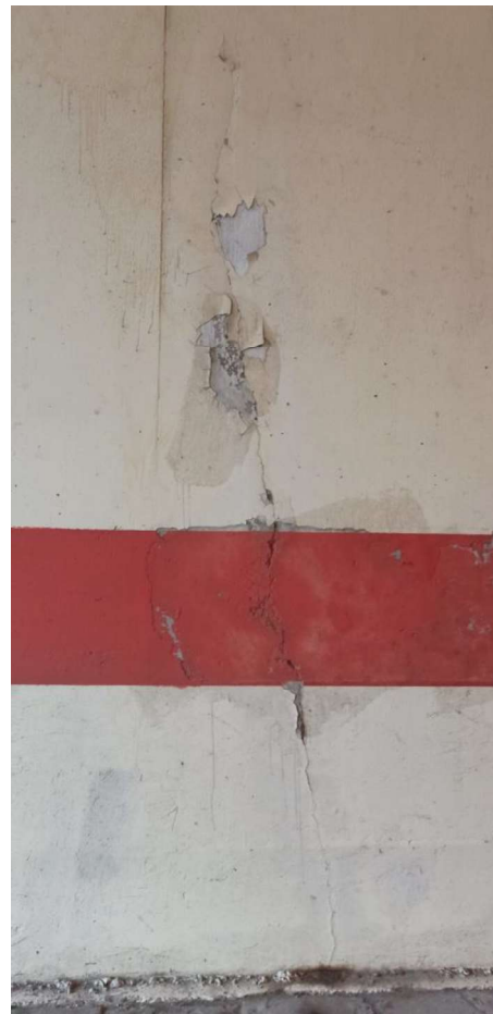
Slika 5: Kampada 2 - PUKOTINE I LJUŠTENJE PREMAZA
