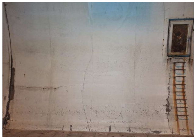
Slika 10: Kampada 5 - KOROZIJA, PUKOTINE, VLAŽENJE I LJUŠTENJE BETONA
