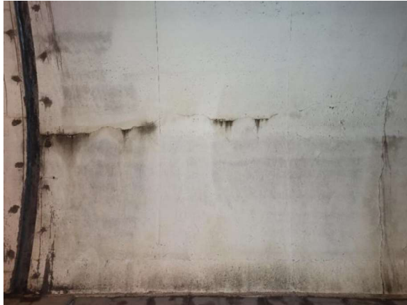
Slika 26: Kampada 63 - PUKOTINE I IZLUŽIVANJE
