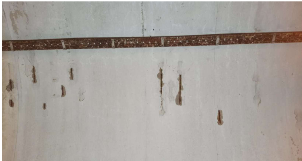
Slika 6: Kampada 3 - ARMATURA I LJUŠTENJE BETONA
