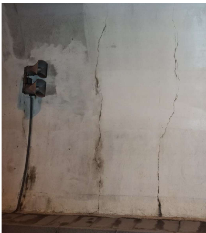
Slika 24: Kampada 57 - IZLOŽENA ARMATURA, KOROZIJA, PUKOTINE I VLAŽENJE
