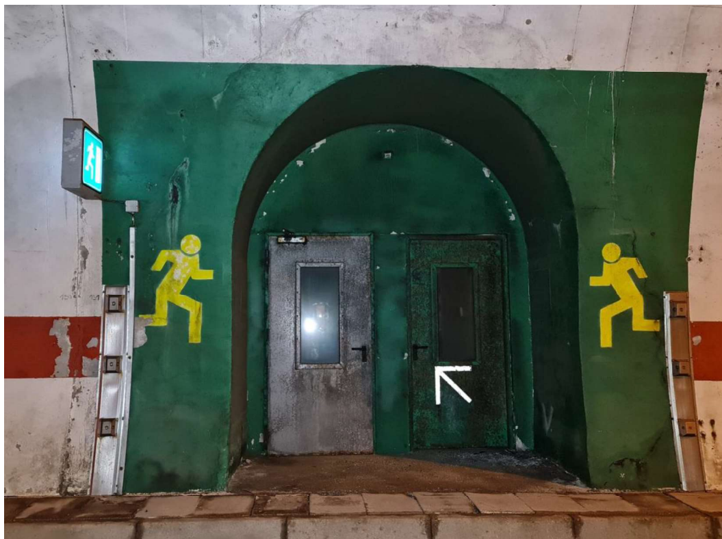
Slika 53: Kampada 151 - PUKOTINE, VLAŽENJE I LJUŠTENJE PREMAZA
