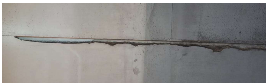
Slika 33: Kampada 75 - PUKOTINE, LJUŠTENJE PREMAZA I BETONA, VLAŽENJE
