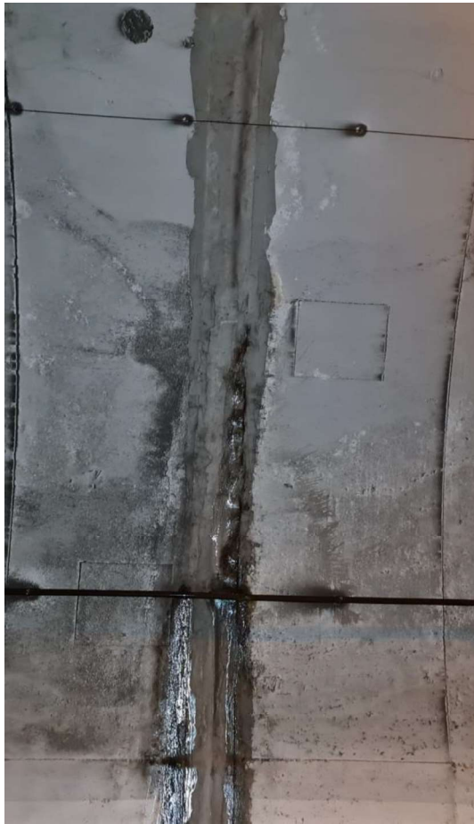
Slika 42: Kampada 115-116 - VLAŽENJE I IZLUŽIVANJE
