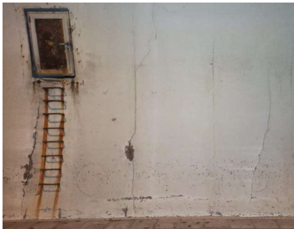
Slika 10: Kampada 5 - KOROZIJA, PUKOTINE, VLAŽENJE I LJUŠTENJE BETONA
