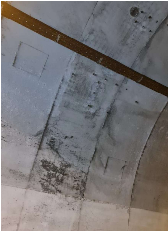
Slika 48: Kampada 130 - SEGREGACIJA BETONA
