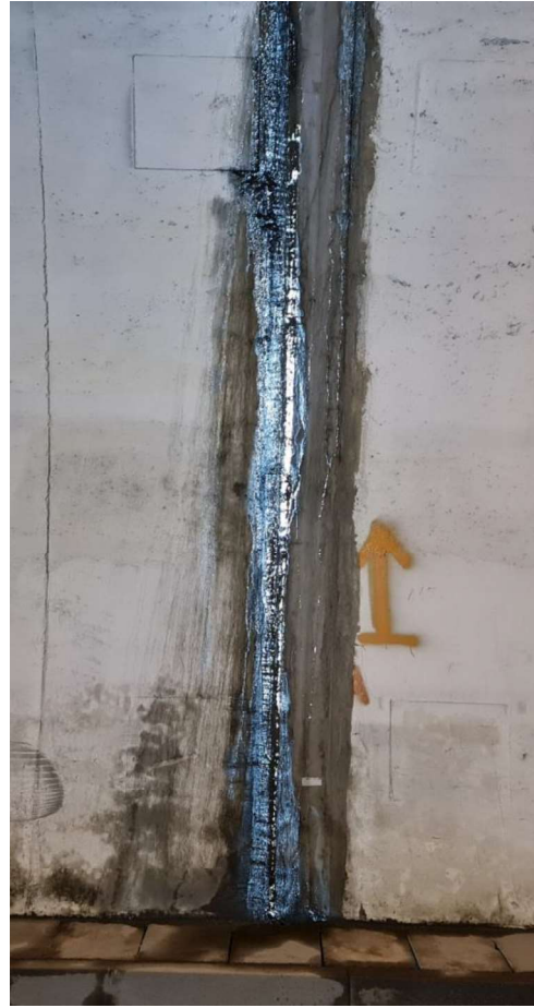
Slika 42: Kampada 115-116 - VLAŽENJE I IZLUŽIVANJE
