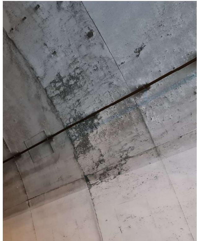
Slika 48: Kampada 130 - SEGREGACIJA BETONA
