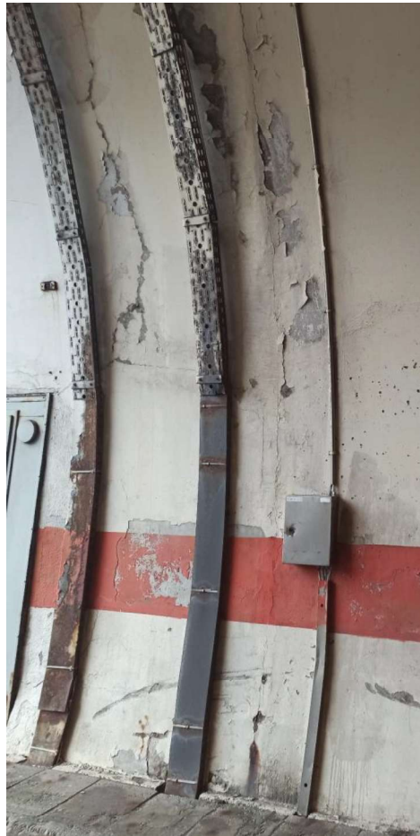
Slika 5: Kampada 2 - PUKOTINE I LJUŠTENJE PREMAZA
