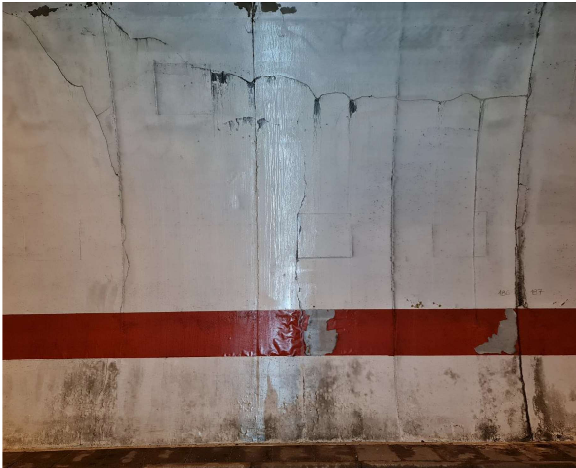
Slika 60: Kampada 186 - PUKOTINA, IZLUŽIVANJE I LJUŠTENJE PREMAZA
