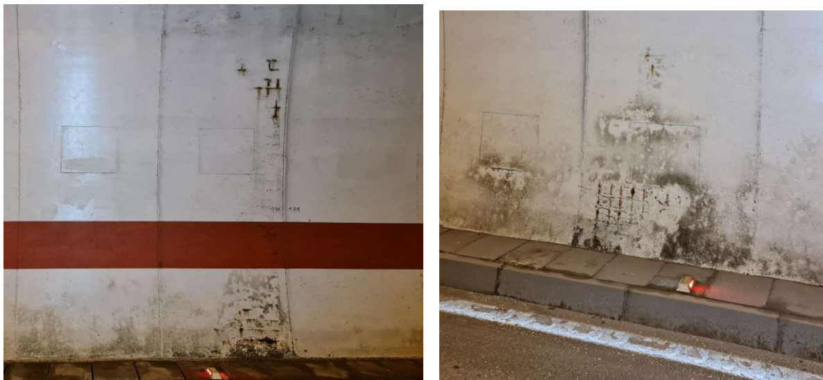
Slika 47: Kampada 130 - ARMATURA BEZ ZAŠTITNOG SLOJA
