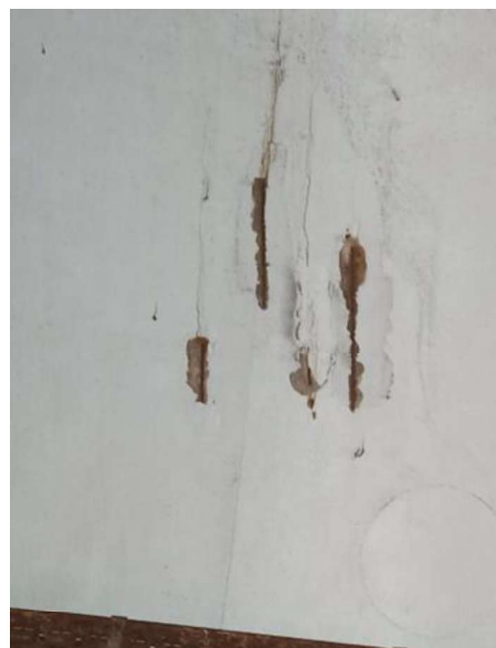
Slika 25: Kampada 57 - IZLOŽENA ARMATURA, KOROZIJA, PUKOTINE I IZLUŽIVANJE
