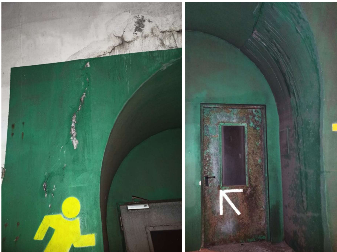
Slika 33: Kampada 75 - PUKOTINE, LJUŠTENJE PREMAZA I BETONA, VLAŽENJE
