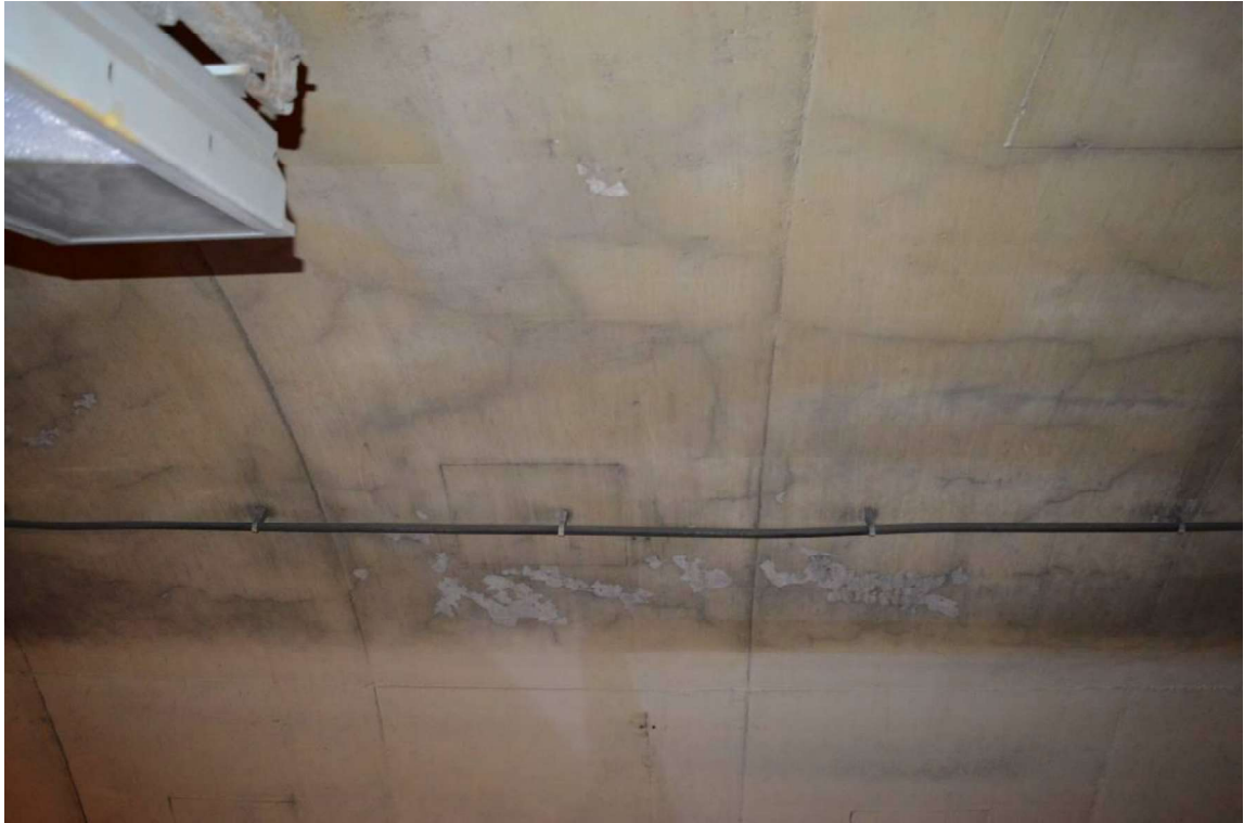
Slika 14: kampada 73 – MREŽASTE PUKOTINE U KALOTI
