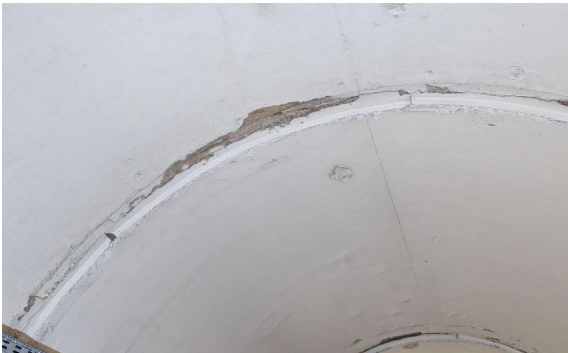
Slika 12: kampada 38 – RADIJALNE/ UZDUŽNE PUKOTINE NA DESNOM BOKU, LJUŠTENJE BETONA SA VLAŽENJEM
