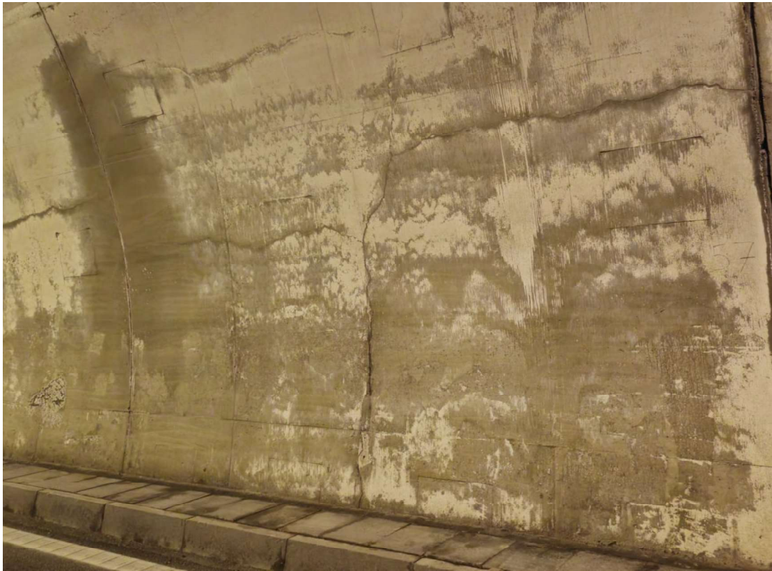
Slika 12: kampada 38 – RADIJALNE/ UZDUŽNE PUKOTINE NA DESNOM BOKU, LJUŠTENJE BETONA SA VLAŽENJEM
