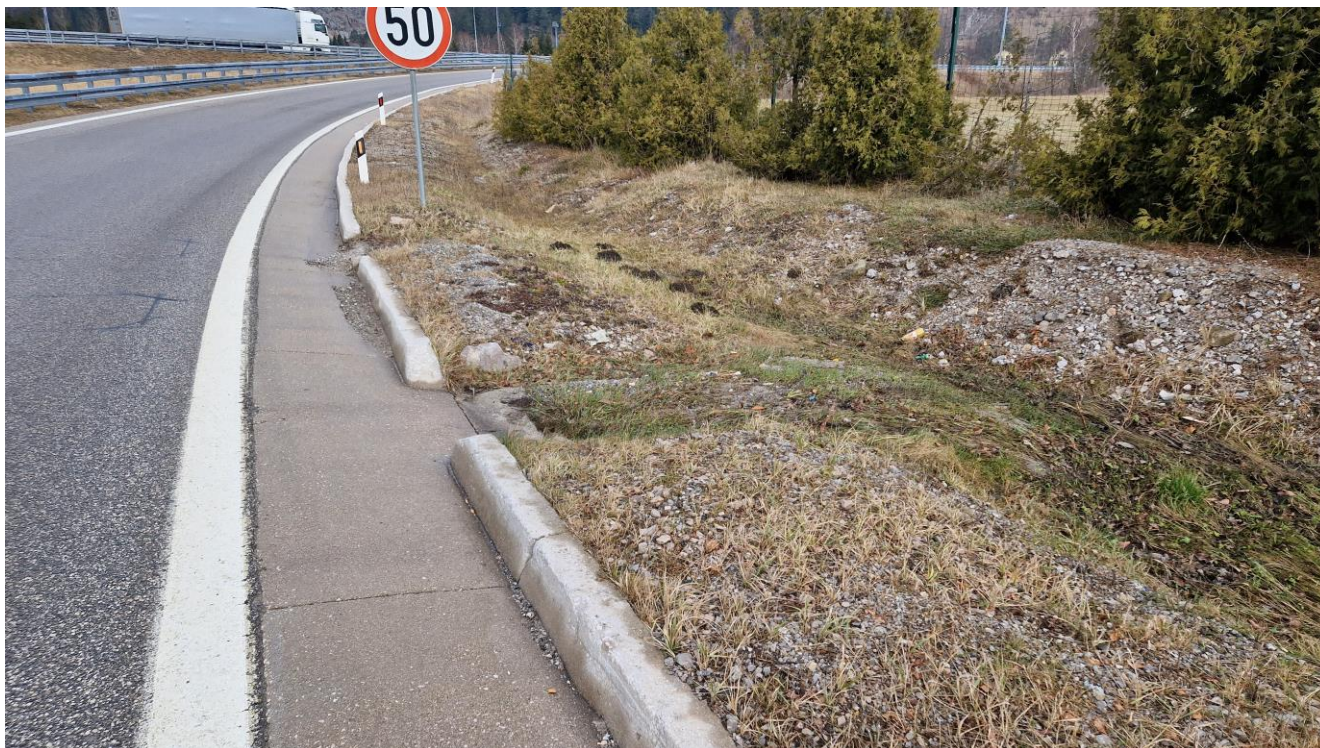
Slika 5. Krak 3 Čvora Vrata_otvor u cestovnom rubnjaku kao ispust rigola_pogled u smjeru AC A6
