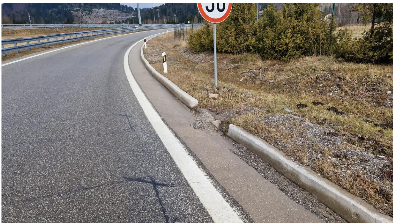
Slika 4. Krak 3 Čvora Vrata_pogled u smjeru AC A6
