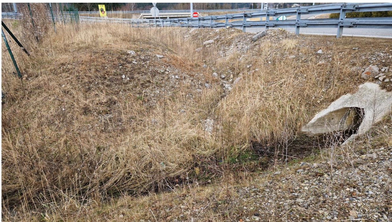
Slika 3. Krak 2 Čvora Vrata_cijevni propust ispod kraka_pogled u smjeru AC A6
