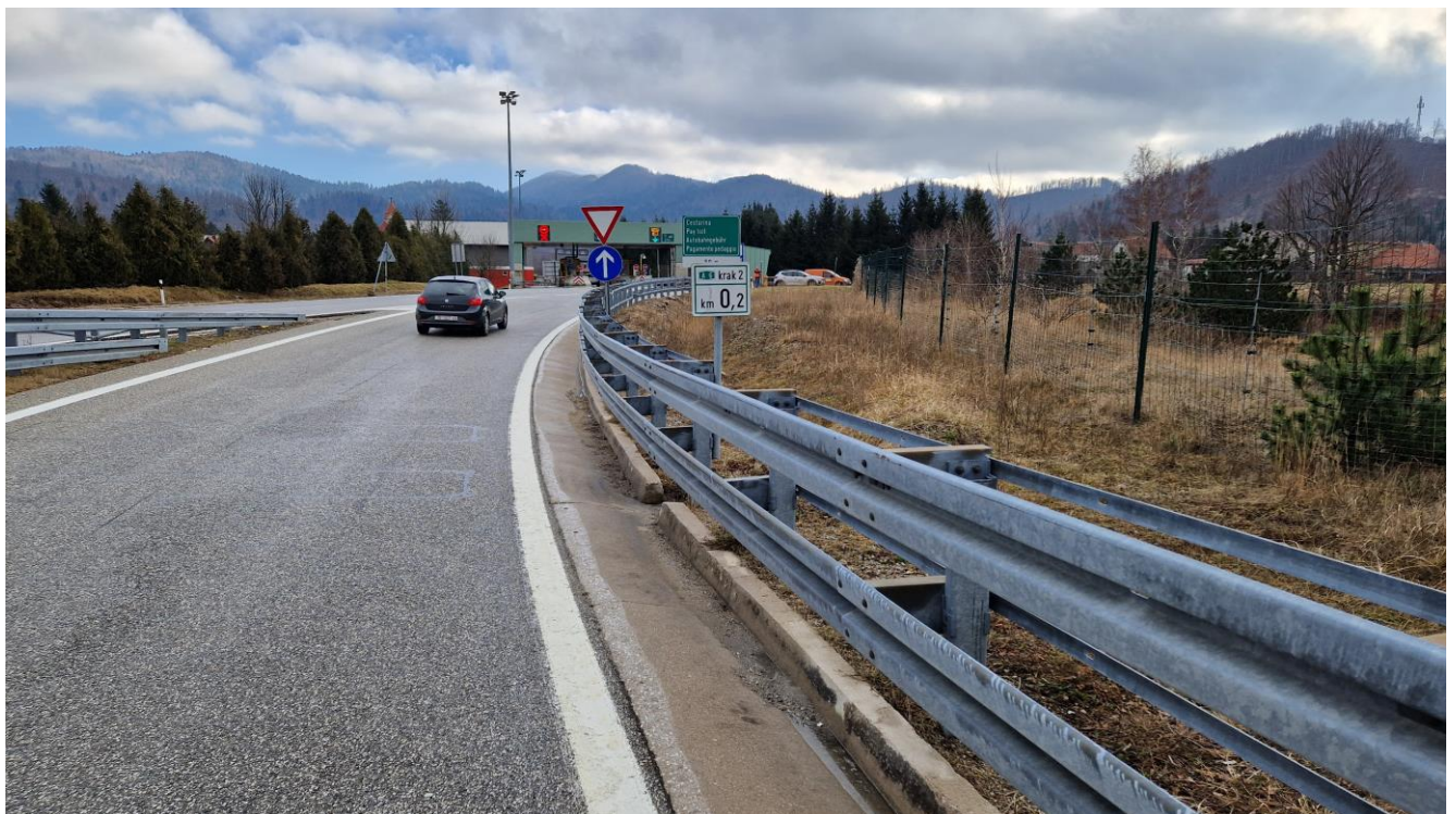
Slika 2. Krak 2 Čvora Vrata_otvor u cestovnom rubnjaku kao ispust rigola_pogled u smjeru NP Vrata
