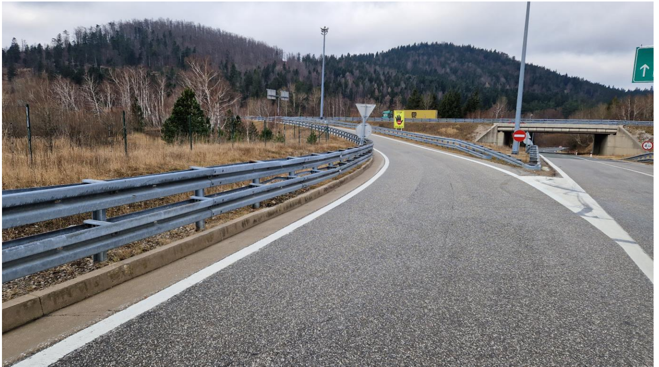
Slika 1. Krak 2 Čvora Vrata_pogled u smjeru AC A6
