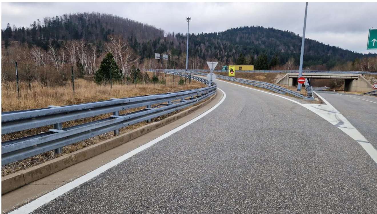
Slika 1. Krak 2 Čvora Vrata_pogled u smjeru AC A6
