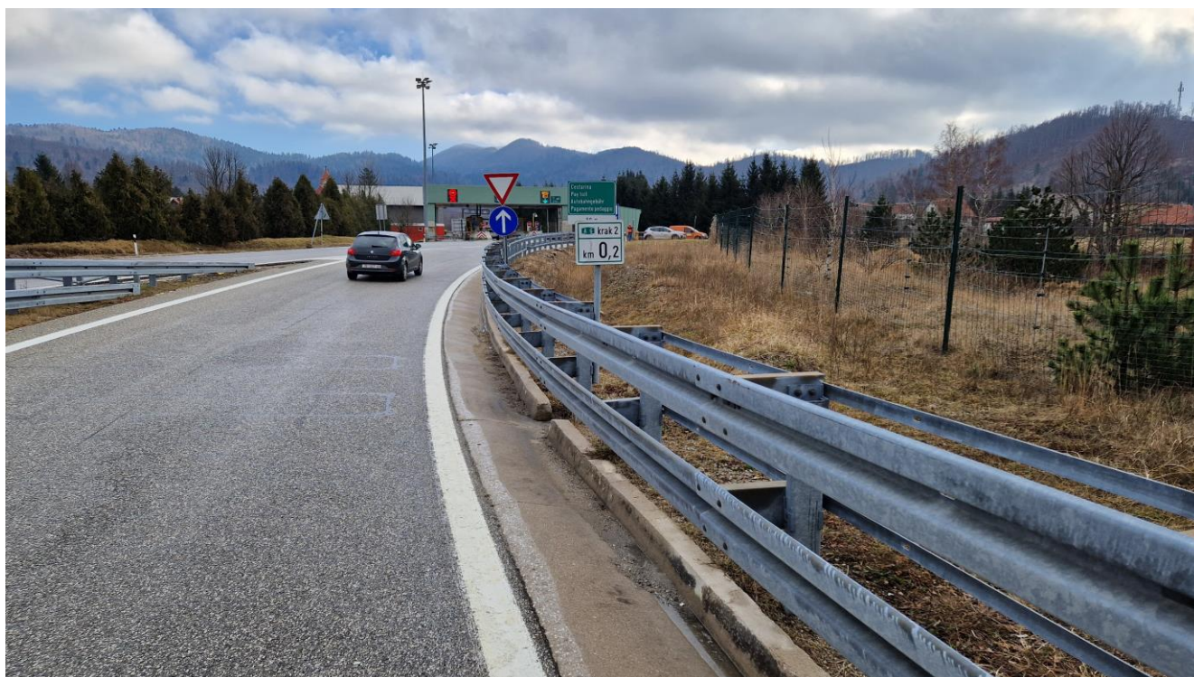
Slika 2. Krak 2 Čvora Vrata_otvor u cestovnom rubnjaku kao ispust rigola_pogled u smjeru NP Vrata
