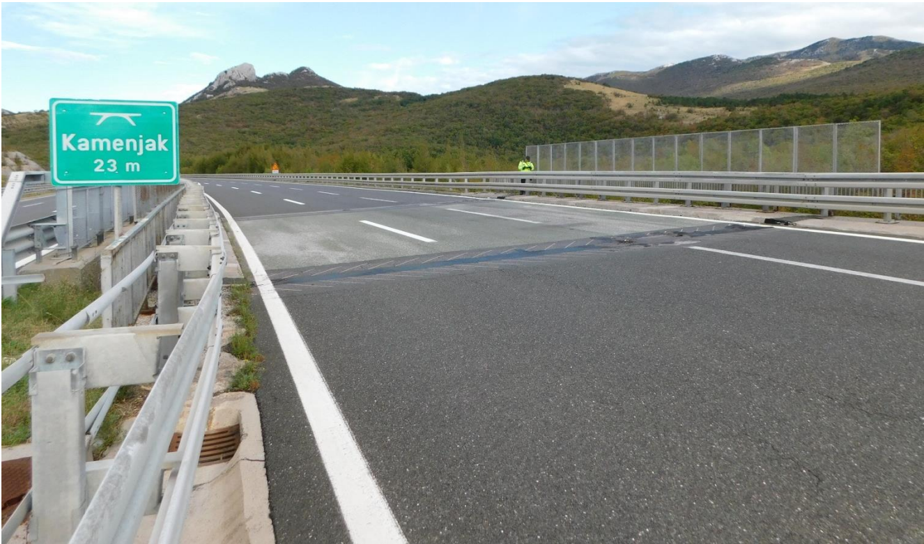
Slika 2. Pogled na prometnu površinu predmetnog mosta, u smjeru rasta stacionaže
