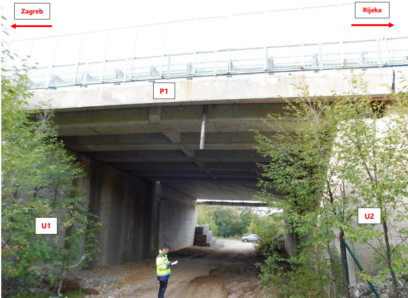
Slika 3. Pogled na desnu stranu predmetnog mosta
