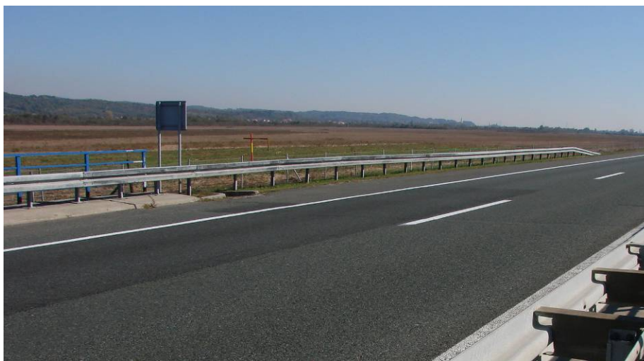
Slika 2.1.3.1.2 Popravak, nizak stupanj oštećenja
