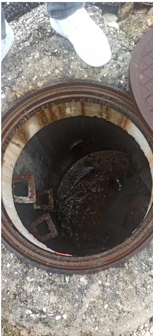
Slika 12 Okno u kojem će se izvršiti zacjevljenje dovodnog cjevovoda DN 300 mm i uvođenje u odvodni cjevovod DN 800 mm
