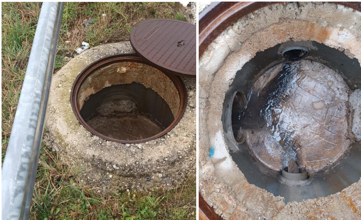
Slika 3 Okno kod kojeg dolazi do prelijevanja vode
