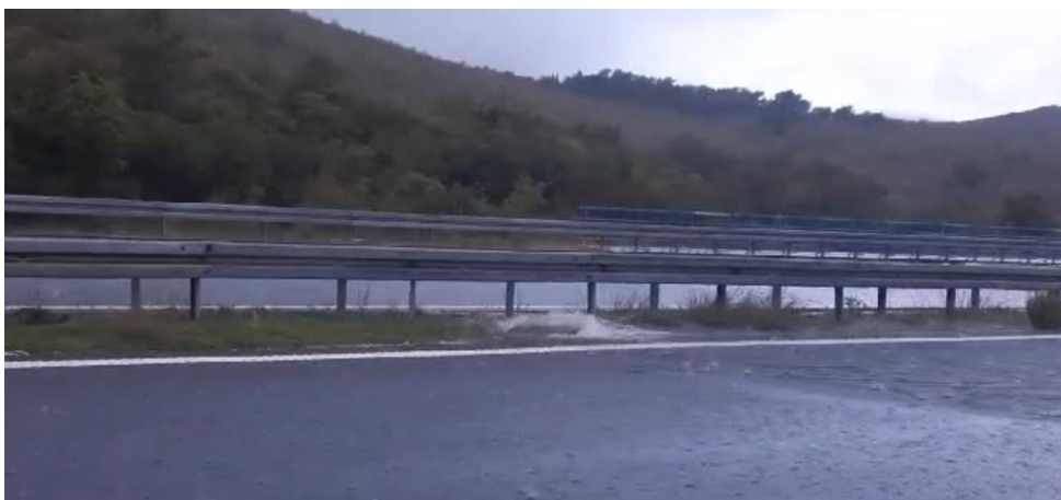
Slika 1 Voda koja izvire iz okna podižući poklopac
