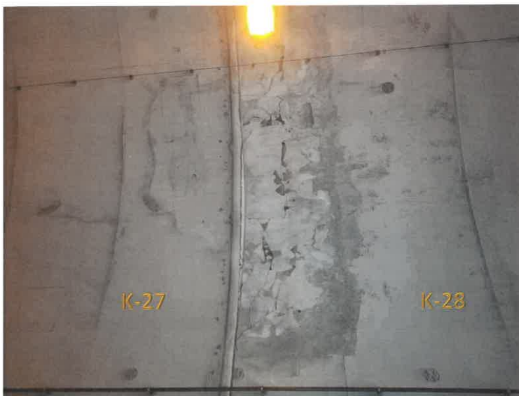
Slika 4. Pogled na kalotu: Vidljivo područje oštećenja obloge na lijevoj strani kalote, kampada 28
