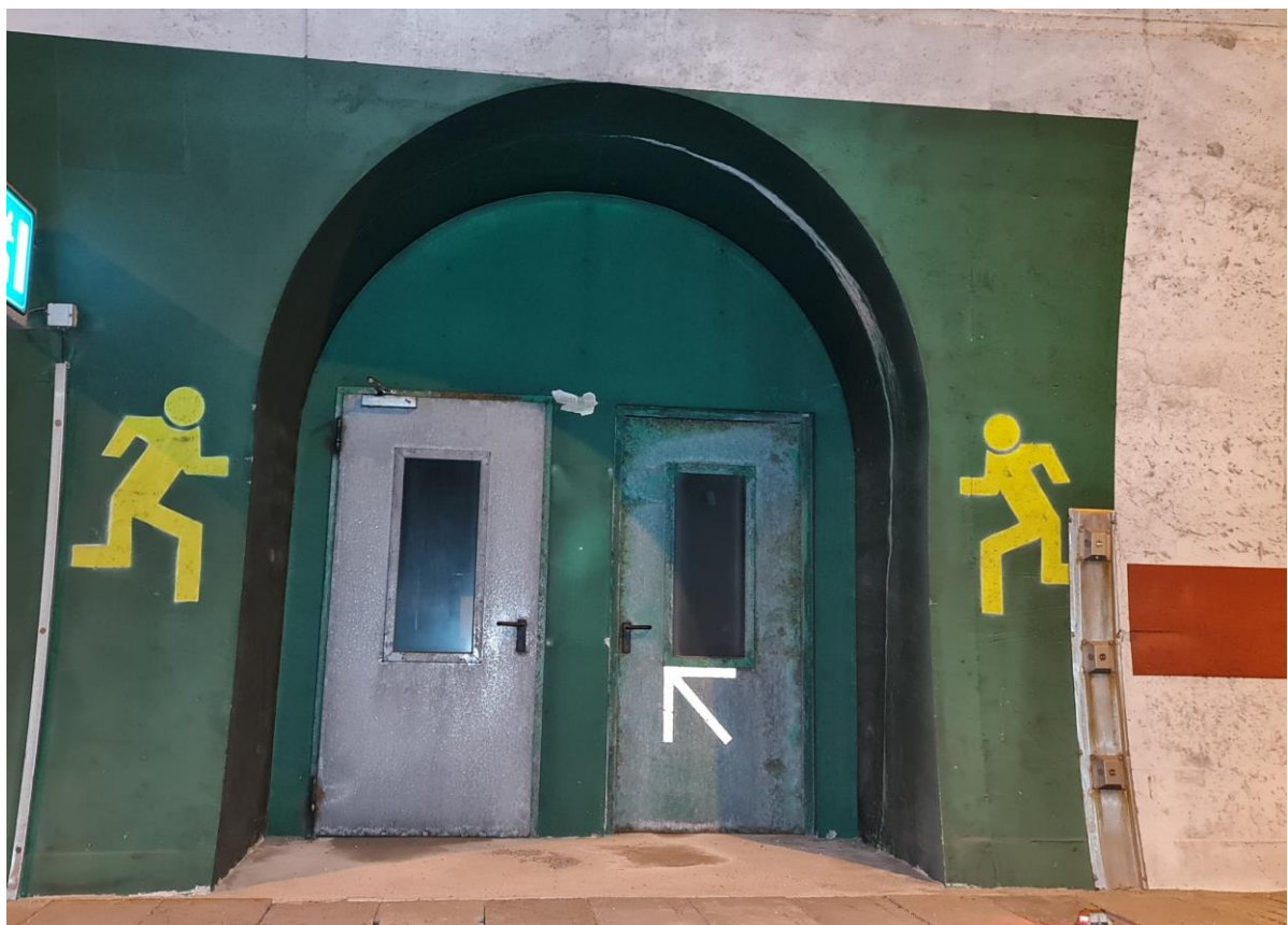
Slika 19: Kampada 112 - PUKOTINA SA IZLUŽIVANJEM, LJUŠTENJE PREMAZA
