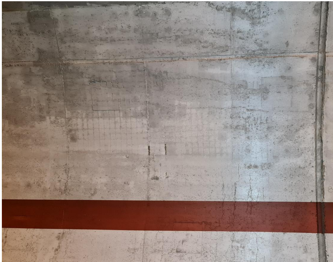
Slika 24: Kampada 86 - SEGREGACIJA, KOROZIJA ARMATURE I NEDOSTATAK ZAŠITNOG SLOJA
