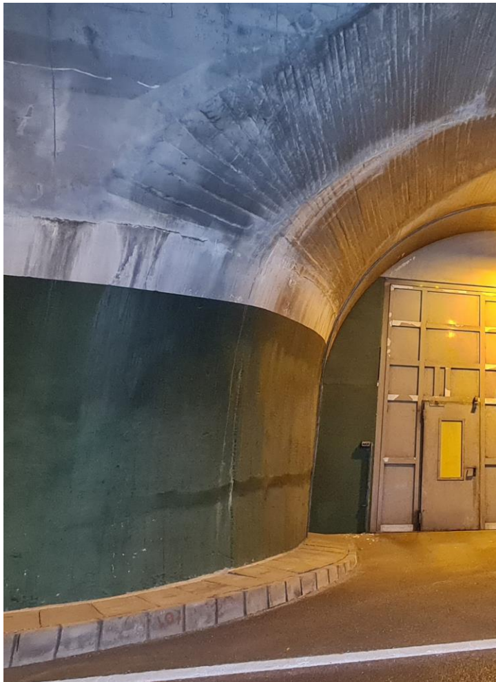
Slika 20: Kampada 91 - RADIJALNE PUKOTINE SA IZLUŽIVANJEM
