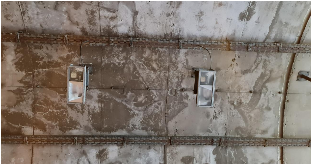
Slika 32: Kampada 3 - SEGREGACIJA I LJUŠTENJE PREMAZA
