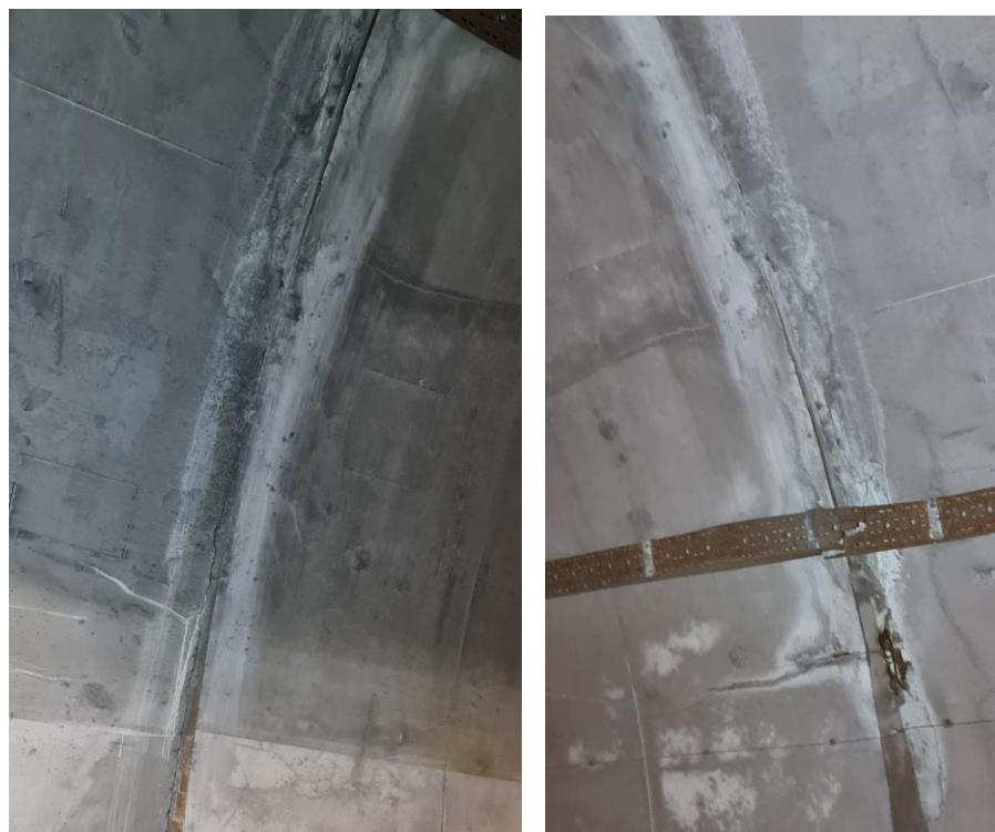
Slika 23: Kampada 90 - LJUŠTENJE I IZLUŽIVANJE SPOJNICE
