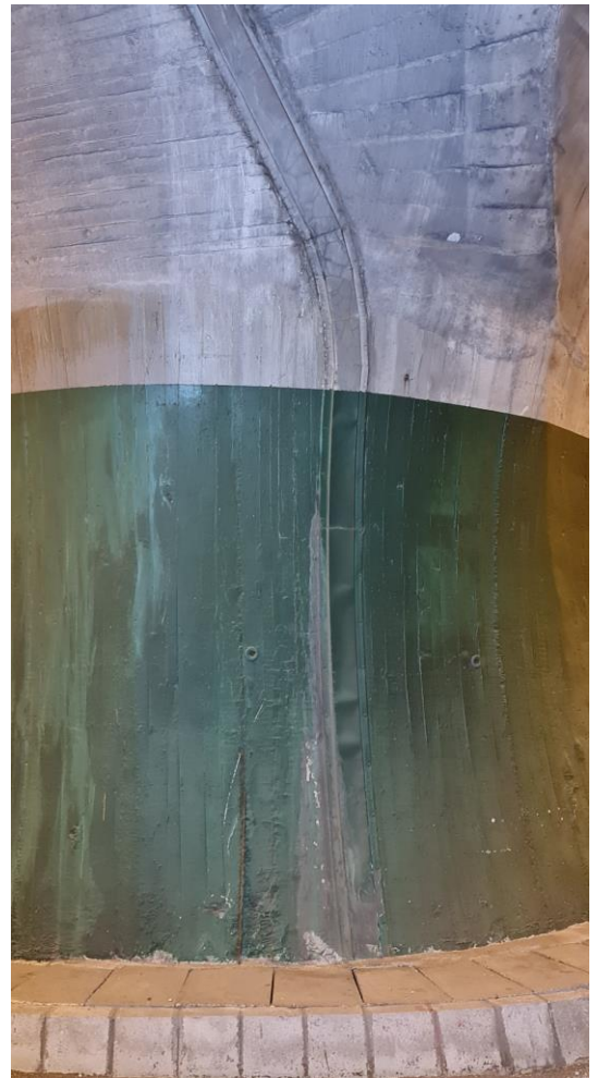
Slika 20: Kampada 91 - RADIJALNE PUKOTINE SA IZLUŽIVANJEM
