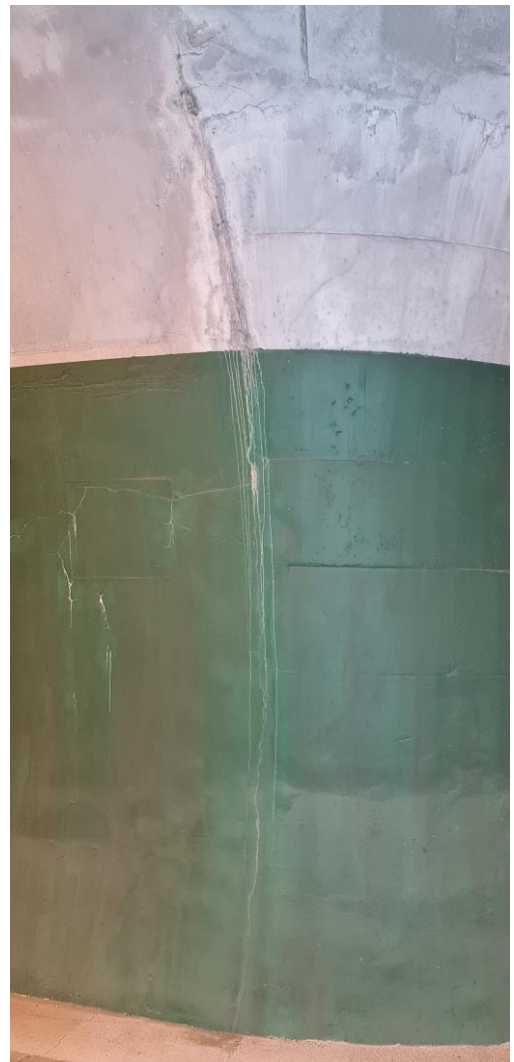
Slika 12: Kampada 148- okretište za automobile - RADIJALNE PUKOTINE SA IZLUŽIVANJEM
