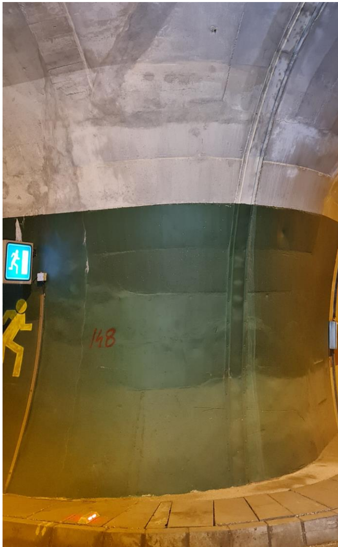
Slika 12: Kampada 148- okretište za automobile - RADIJALNE PUKOTINE SA IZLUŽIVANJEM
