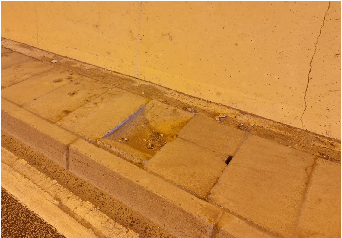
Slika 7: Kampada 181 - RUNIRANJE AB PLOČE HODNIKA
