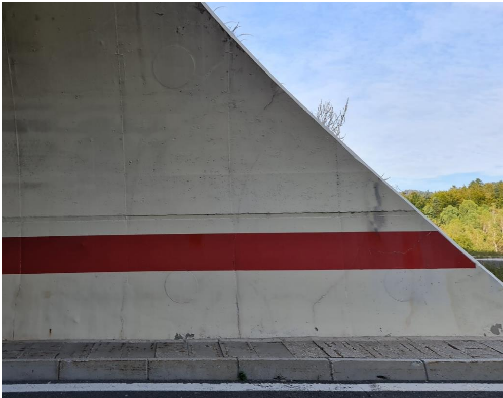
Slika 35: ulazni portal - MREŽASTE PUKOTINE, KOROZIJA I LJUŠTENJE AB PLOČA HODNIKA
