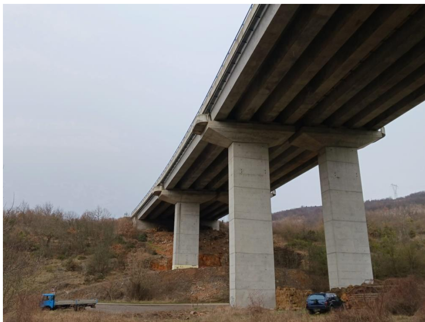
Slika 1.2-1 Pogled na podgled objekta
