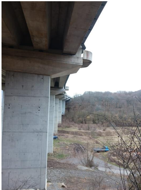
Slika 1.2-2 Pogled na podgled objekta
