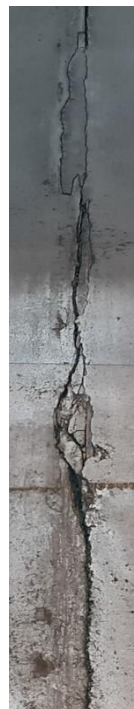
Slika 19: ODLAMANJE U SPOJNICAMA
