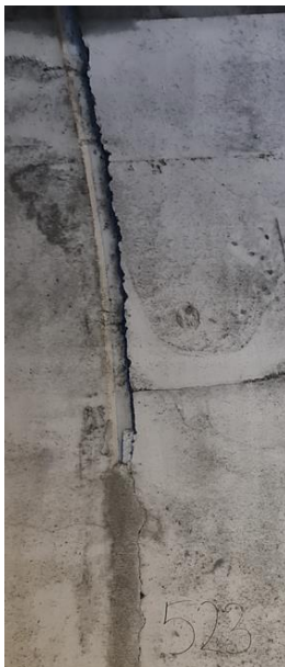
Slika 8: Kampada 554 – ODLAMANJE BETONSKE PLOČE HODNIK, PUKOTINE
