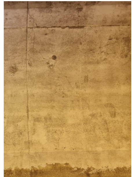
Slika 8: Kampada 554 – ODLAMANJE BETONSKE PLOČE HODNIK, PUKOTINE
