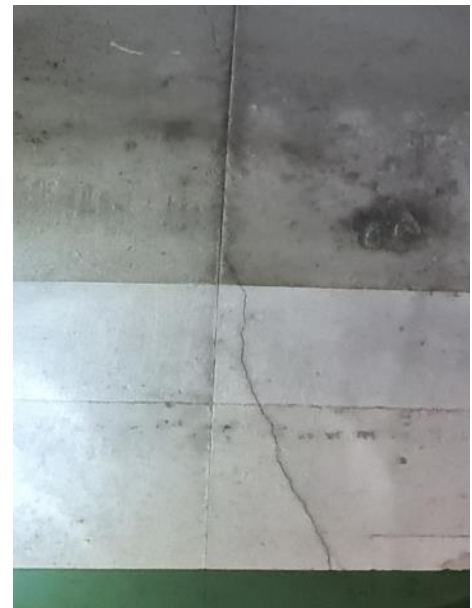
Slika 8: Kampada 554 – ODLAMANJE BETONSKE PLOČE HODNIK, PUKOTINE
