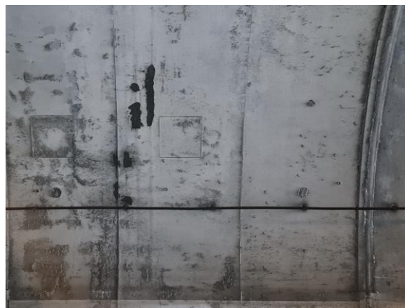
Slika 37: Kampada 196 – ARMATURA, SEGREGACIJA
