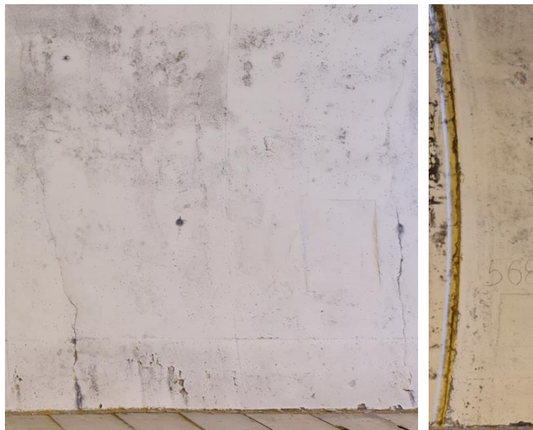
Slika 5: Kampada 570 – ODLAMANJE U SPOJNICAMA
