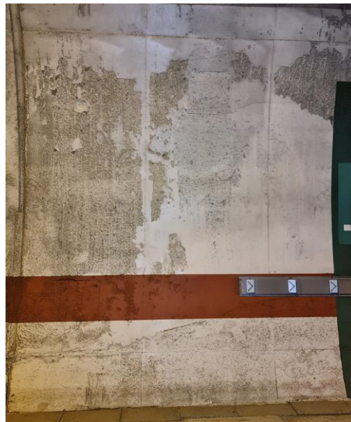
Slika 8: Kampada 554 – ODLAMANJE BETONSKE PLOČE HODNIK, PUKOTINE
