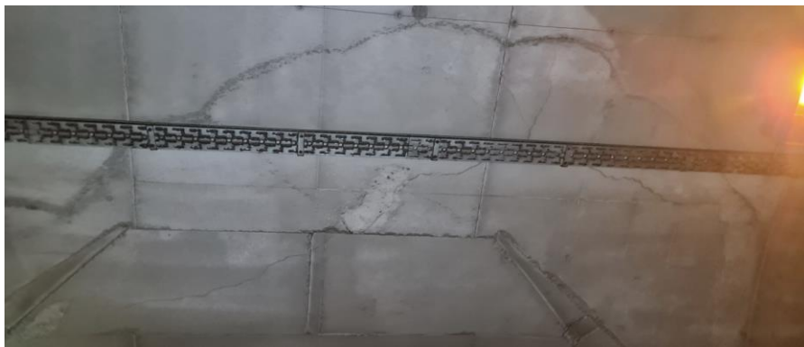
Slika 15: Kampada 469 – ODLAMANJE U SPOJNICAMA
