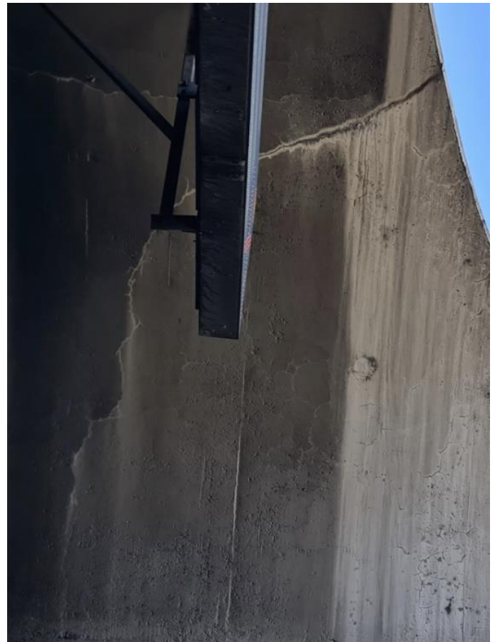
Slika 49: Kampada 1 – LJUŠTENJE, SEGREGACIJA, OŠTEĆENJE BOJE, PUKOTINE
