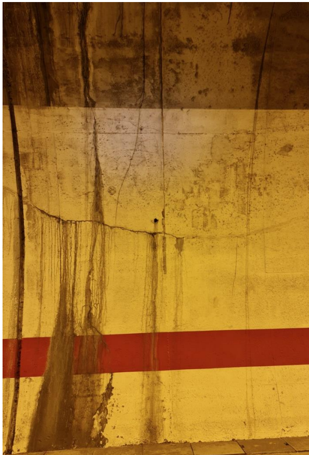
Slika 7: Kampada 560 – PUKOTINE, PROCJEĐIVANJE
