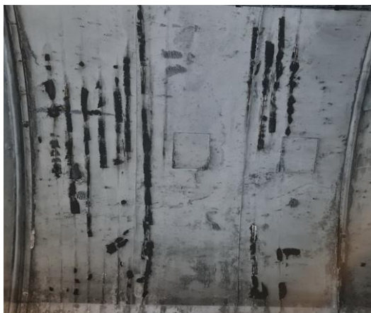
Slika 37: Kampada 196 – ARMATURA, SEGREGACIJA
