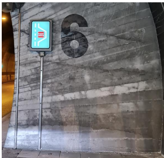
Slika 35: PUKOTINE, PROCJEDIVANJE
