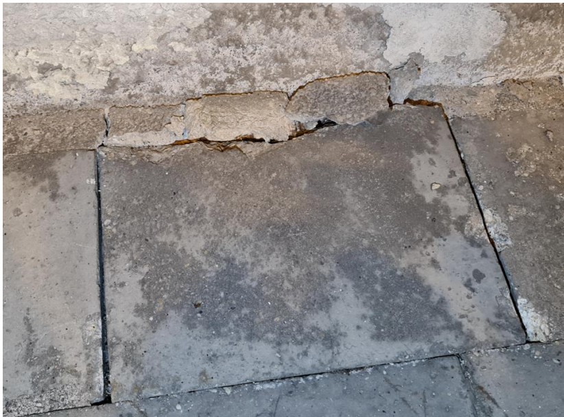
Slika 8: Kampada 554 – ODLAMANJE BETONSKE PLOČE HODNIK, PUKOTINE
