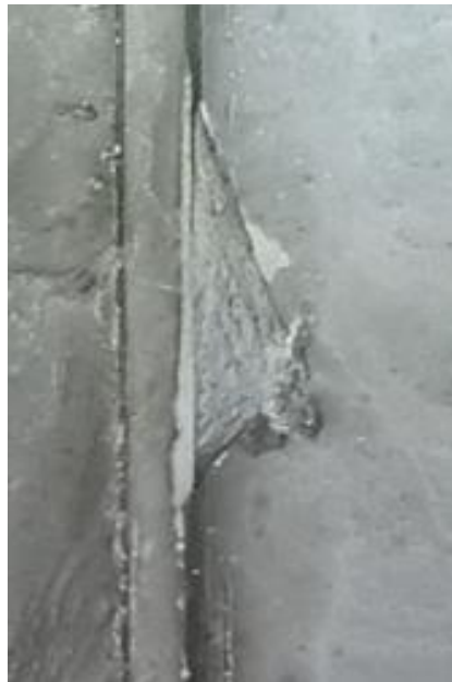
Slika 15: Kampada 469 – ODLAMANJE U SPOJNICAMA
