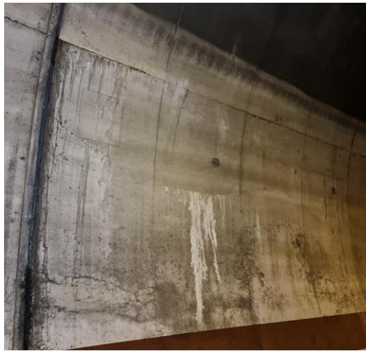
Slika 32: PUKOTINE, PROCJEĐIVANJE
