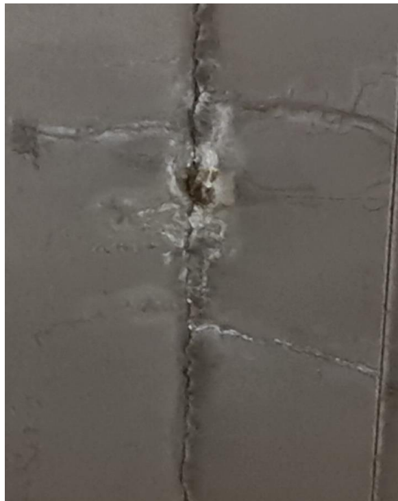
Slika 45: Kampada 72 – ODLAMANJE U SPOJNICAMA
