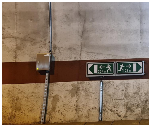
Slika 24: Kampada 361 – PUKOTINE, PROCJEDIVANJE
