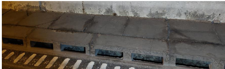
Slika 14: Kampada 12 - ODLAMANJE BETONSKIH PLOČA HODNIKA
