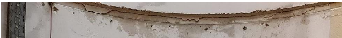
Slika 5: Kampada 3 – ODLAMANJE NA SPOJNICAMA
