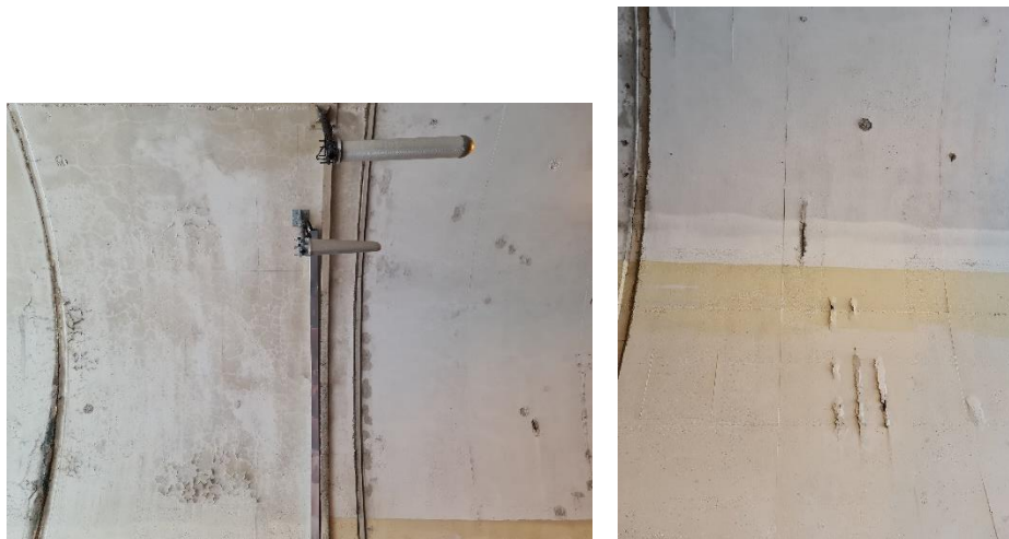
Slika 4: Kampada 2 – ARMATURA, LJUŠTENJE
