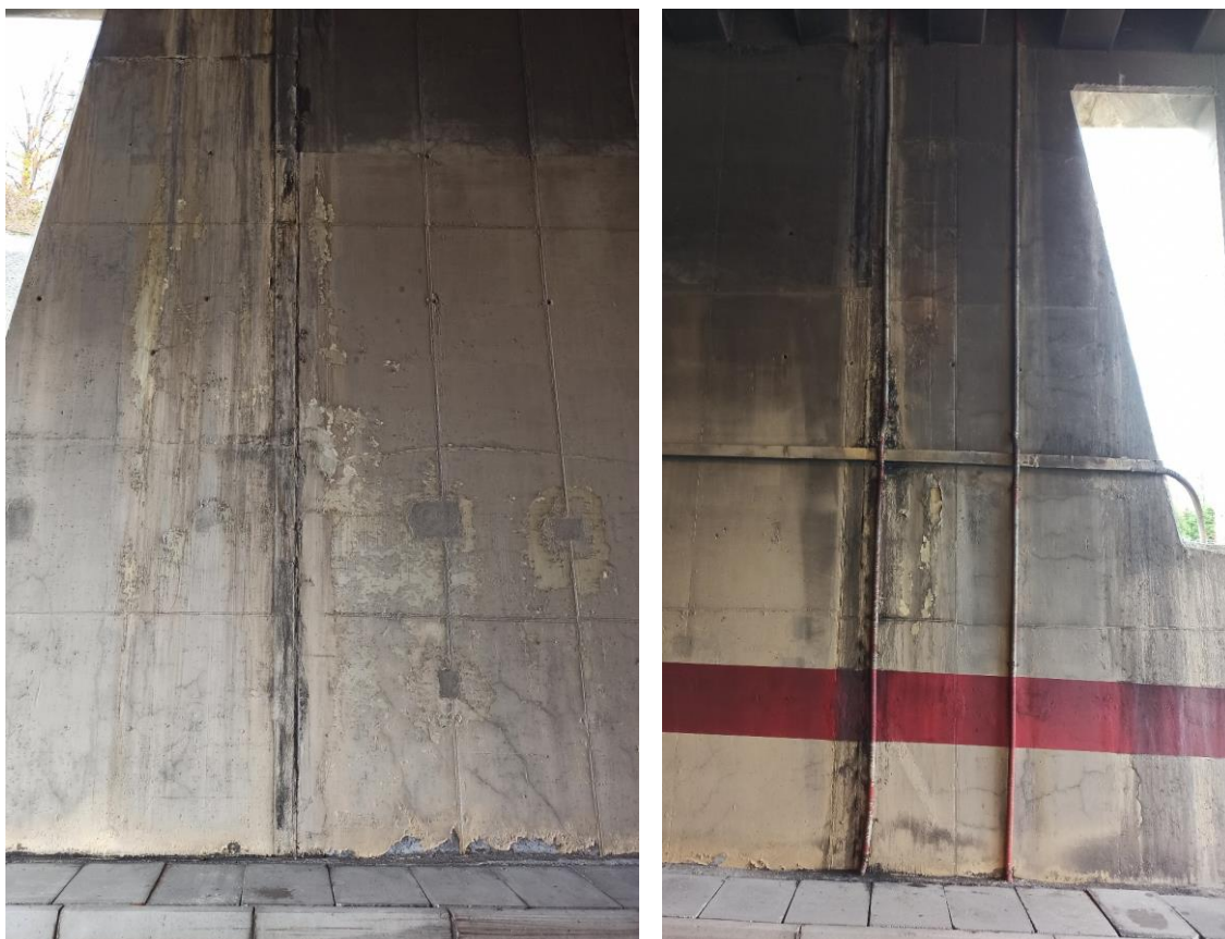
Slika 39: Izlazni portal - PROCJEĐIVANJE I LJUŠTENJE PREMAZA
