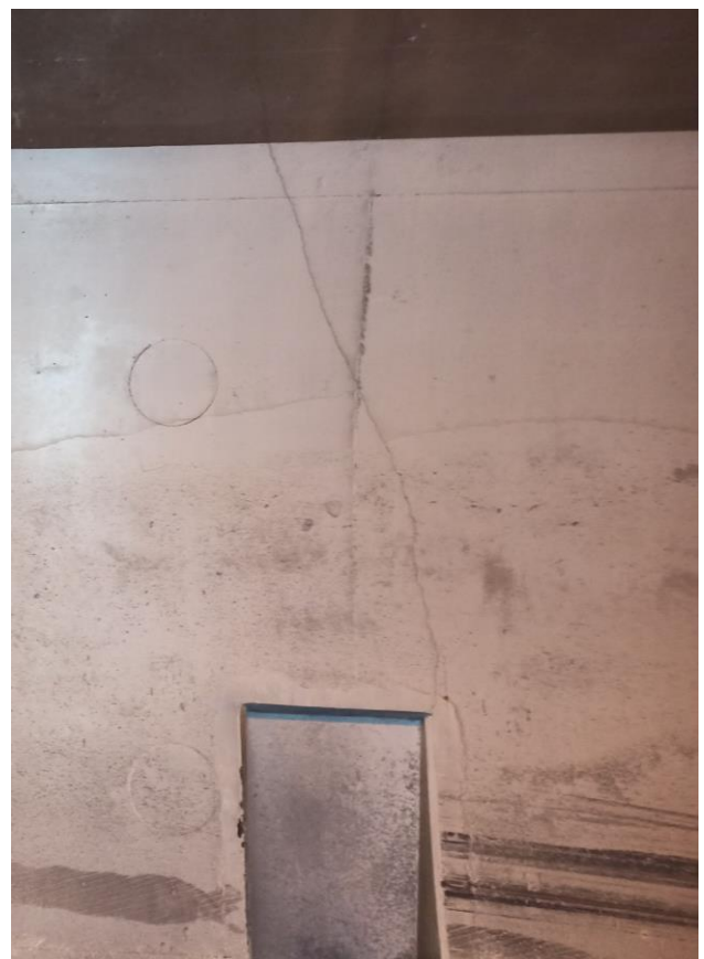
Slika 16: Kampada 104 - UZDUŽNE I RADIJALNE PUKOTINE
