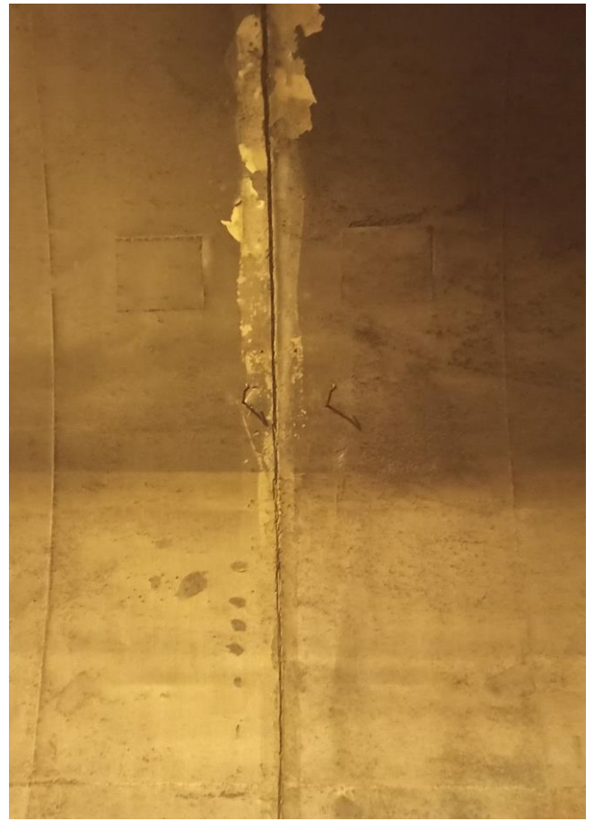
Slika 31: Kampada 435 - LJUŠTENJE PREMAZA NA SPOJNICI
