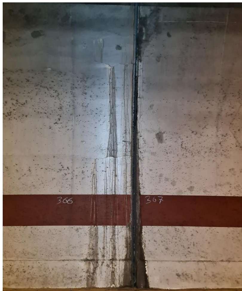
Slika 26: Kampada 366 - CURENJE I LUŽENJE NA SPOJNICI
