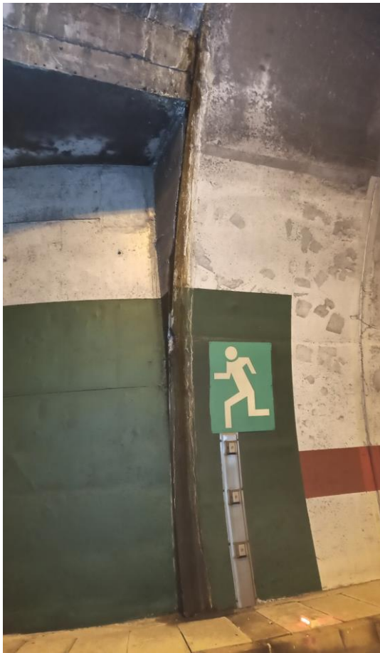
Slika 21: Okretište za automobile 4 - LJUŠTENJE BETONA I CURENJE/ IZLUŽIVANJE
