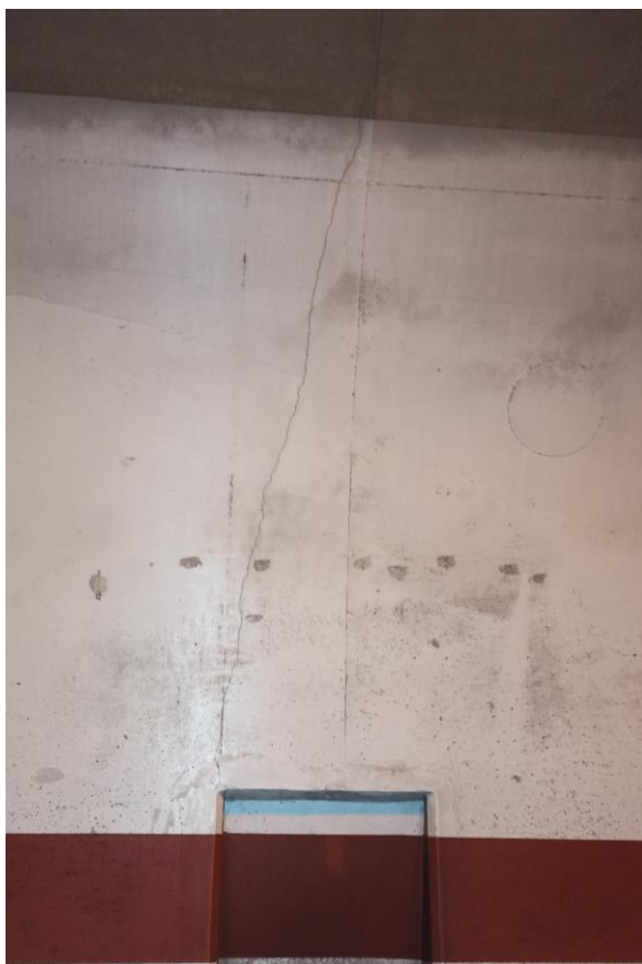
Slika 16: Kampada 104 - UZDUŽNE I RADIJALNE PUKOTINE
