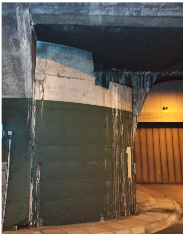
Slika 30: Okretište za automobile 1 - LJUŠTENJE BETONA I CURENJE/ IZLUŽIVANJE
