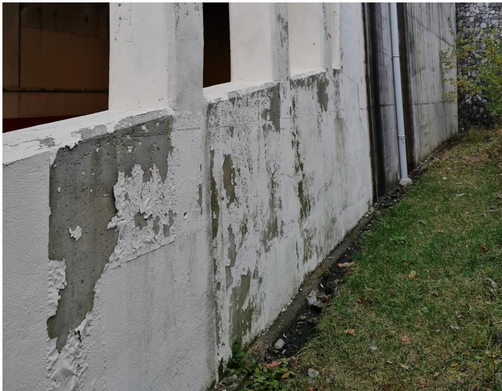
Slika 1: Ulazni portal – LJUŠTENJE PREMAZA BETONA
