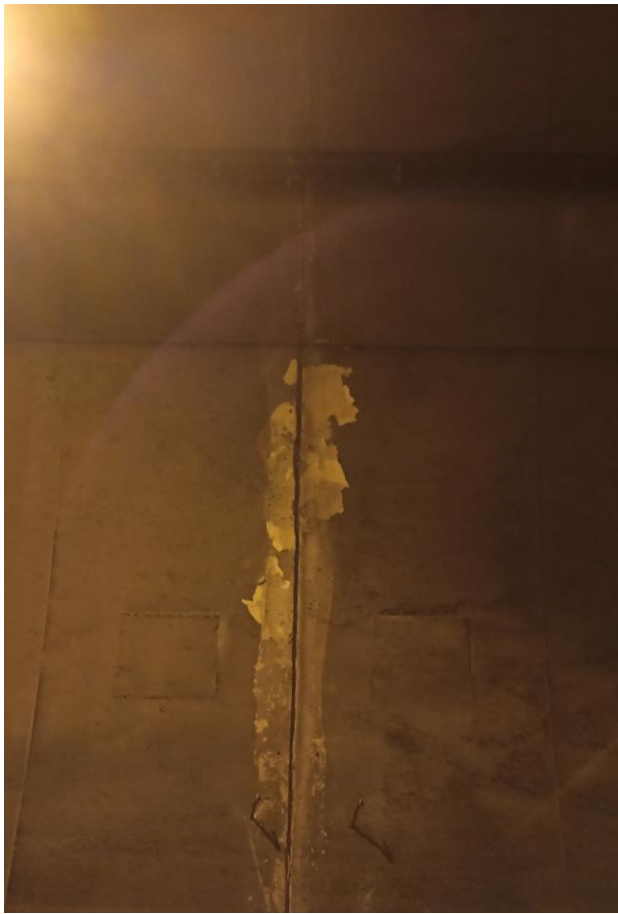
Slika 31: Kampada 435 - LJUŠTENJE PREMAZA NA SPOJNICI
