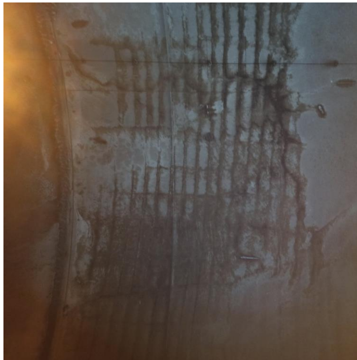
Slika 22: Kampada 241 - NEDOSTATAK ZAŠITNOG SLOJA, VIDLJIVA ARMATURA
