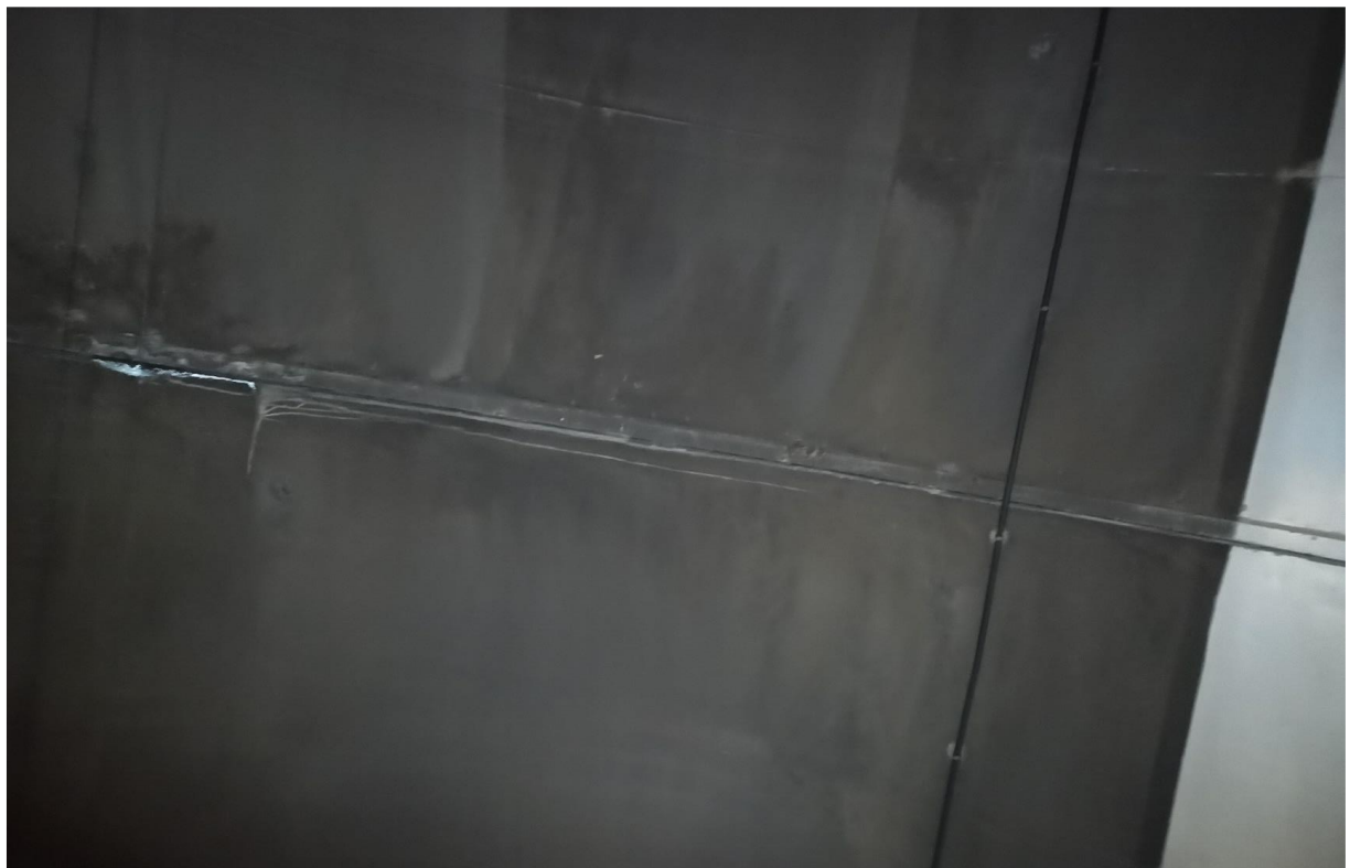
Slika 20: Kampada 207 - CURENJE NA SPOJNICI
