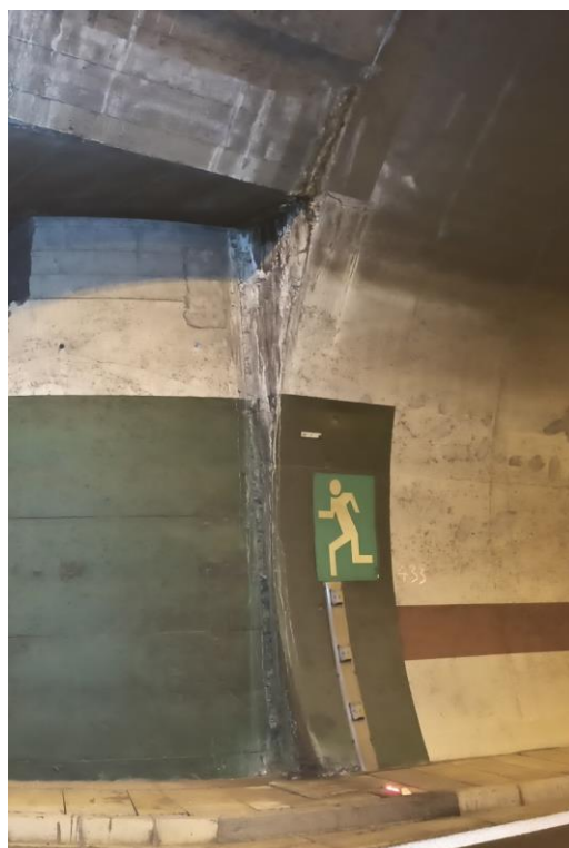
Slika 30: Okretište za automobile 1 - LJUŠTENJE BETONA I CURENJE/ IZLUŽIVANJE
