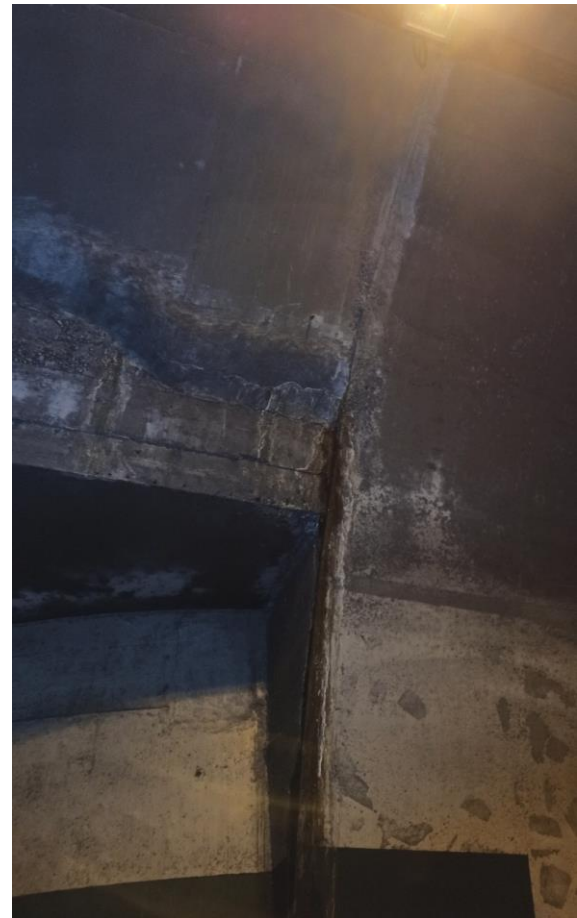
Slika 21: Okretište za automobile 4 - LJUŠTENJE BETONA I CURENJE/ IZLUŽIVANJE
