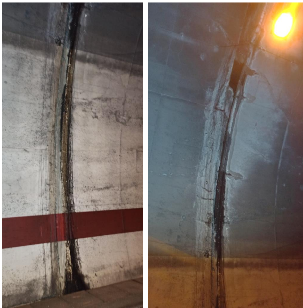
Slika 30: kampada 211 - VLAŽENJE I LUŽENJE NA SPOJNICI
