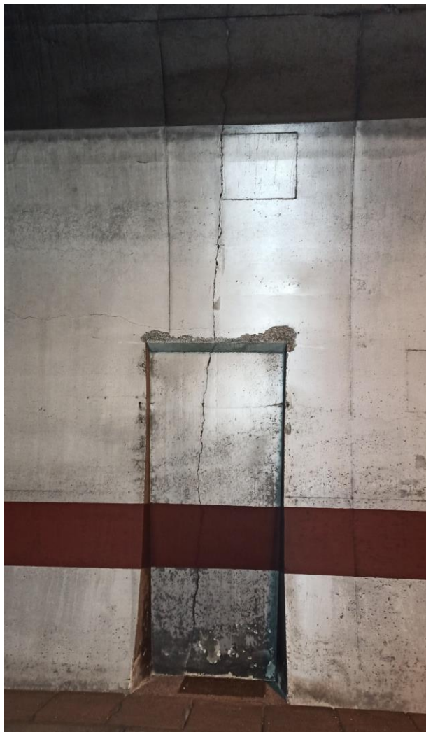
Slika 32: kampada 281/285 - RADIJALNE PUKOTINE
