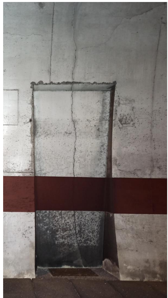
Slika 32: kampada 281/285 - RADIJALNE PUKOTINE
