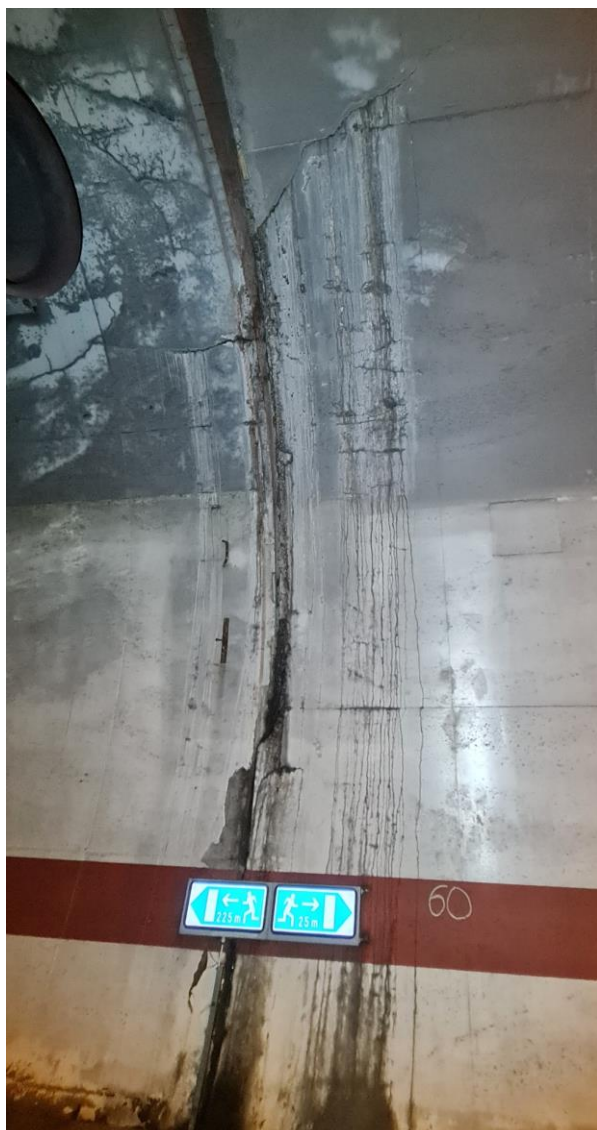
Slika 19: kampada 60 - IZLUŽIVANJE I LJUŠTENJE NA SPOJNICI
