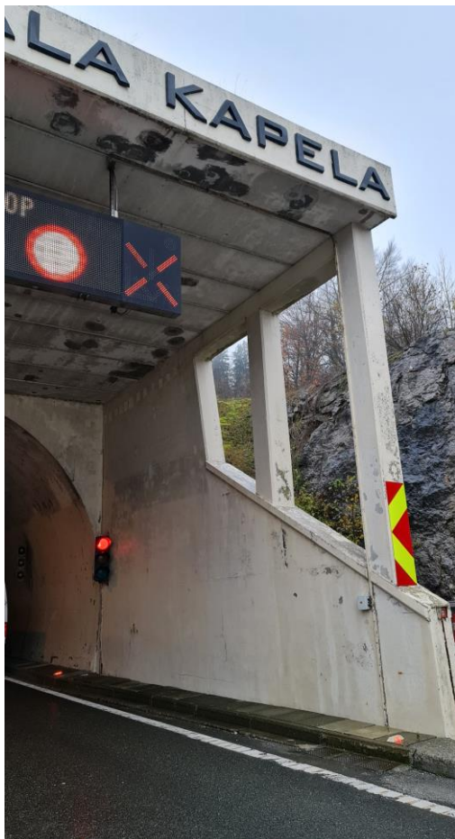
Slika 1: Ulazni portal - LJUŠTENJE PREMAZA BETONA
