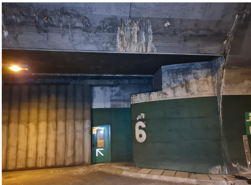
Slika 41: okretište za automobile 6 - IZLUŽIVANJE, ISCVJETAVANJE I LJUŠTENJE PREMAZA
