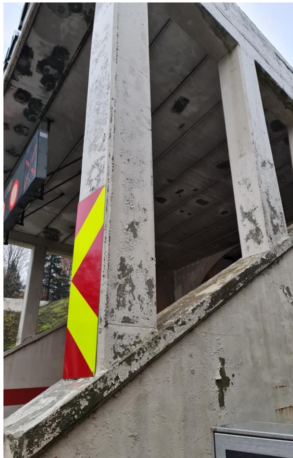
Slika 1: Ulazni portal - LJUŠTENJE PREMAZA BETONA
