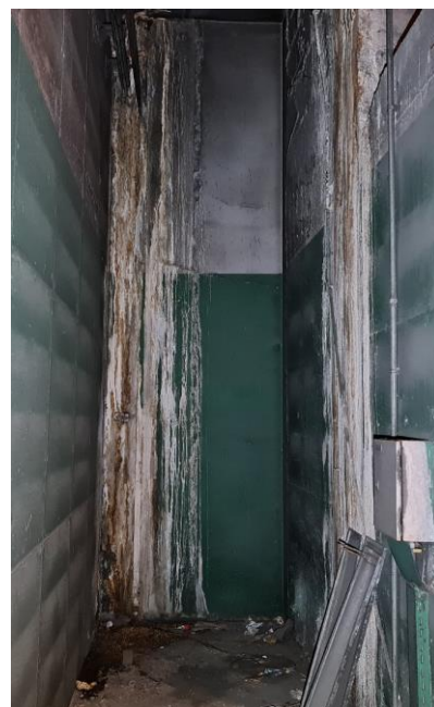
Slika 41: okretište za automobile 6 - IZLUŽIVANJE, ISCVJETAVANJE I LJUŠTENJE PREMAZA
