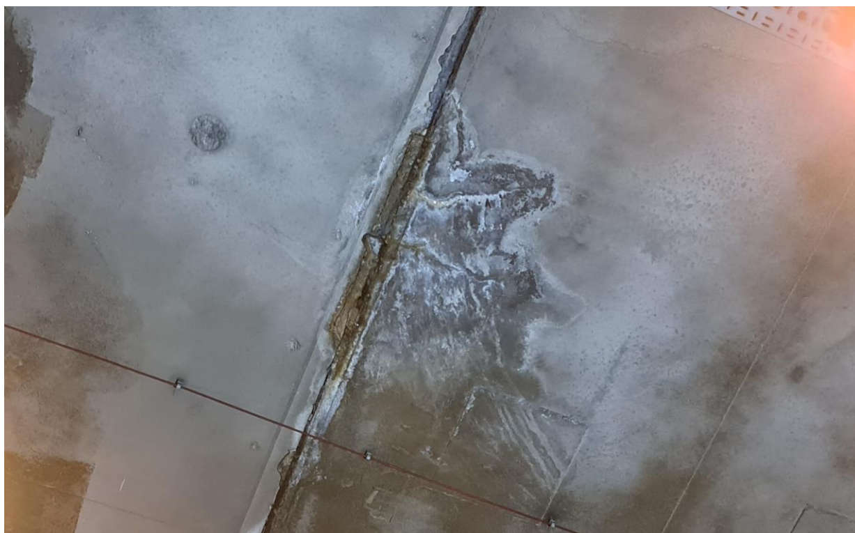
Slika 10: Dilatacijska reška između kampada 39 i 40 - PROCURIVANJE I CVJETANJE NA SPOJNICI
