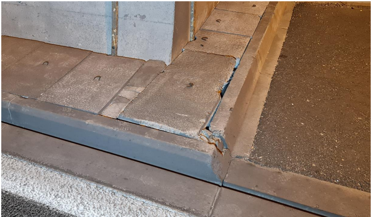
Slika 10: Kampada 39 - ODLAMANJE PREDGOTOVljENE AB PLOČE HODNIKA
