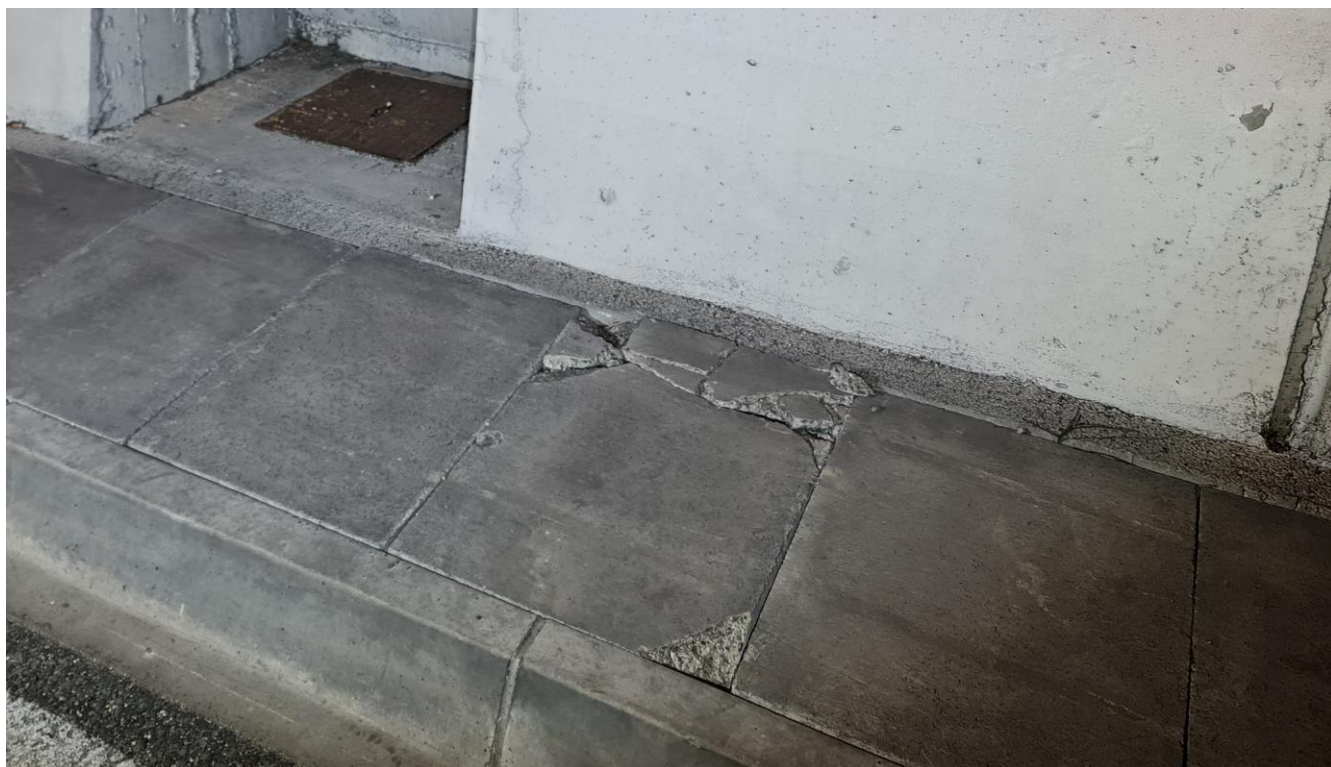
Slika 5: Hodnik - ODLAMANJE PREDGOTOVLJENE AB PLOČE
