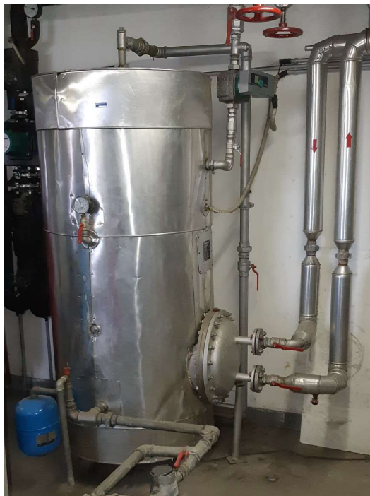
Slika 1. Postojeći spremnik PTV-a sa pripadajućom opremom
