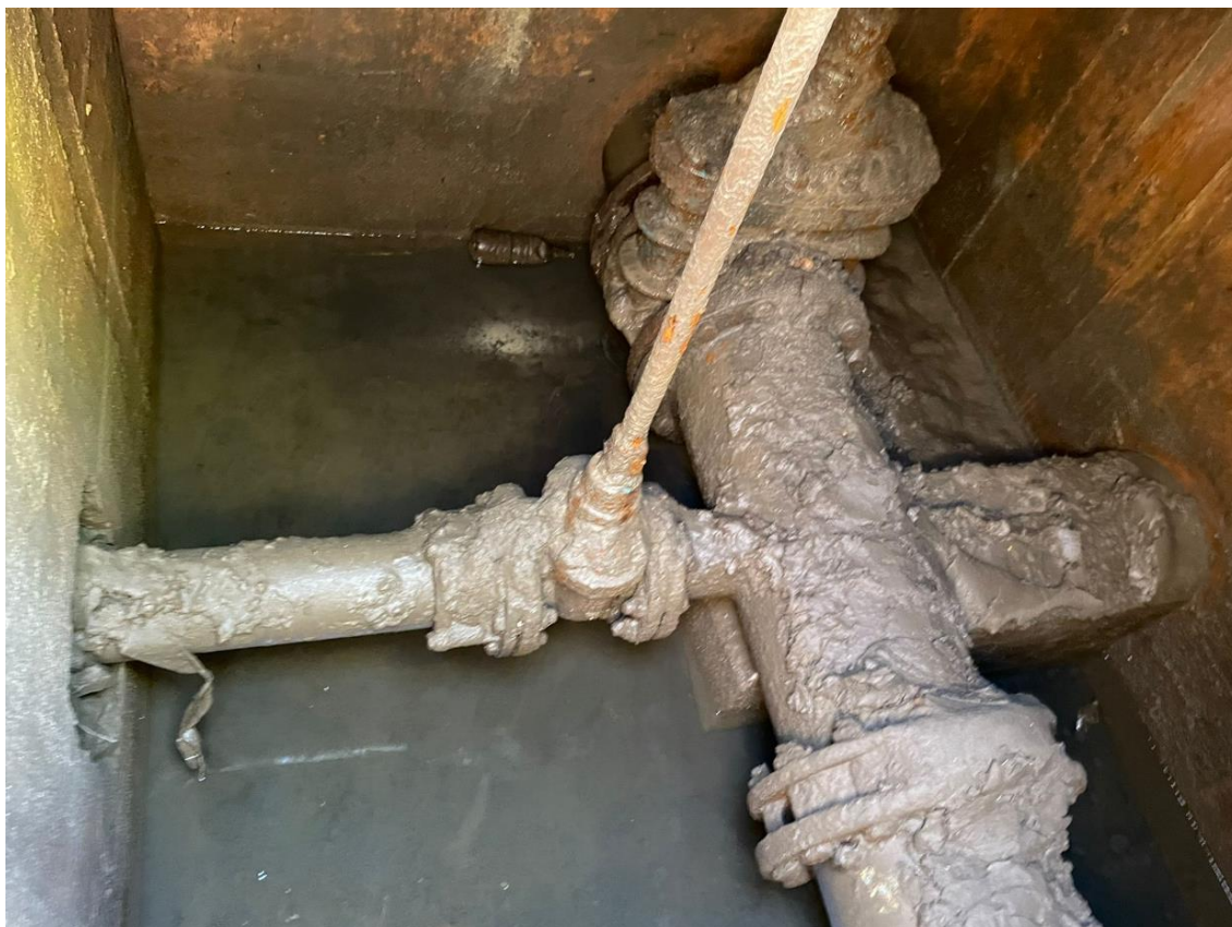
Slika 1 ZK 6630 – križanje s Puškarićevom ulicom DC1
