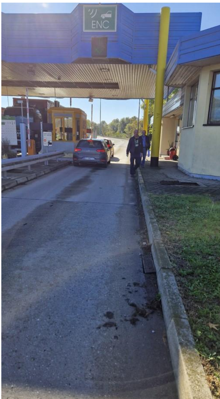
Slika 1. Pogled na kanal linijske odvodnje ( ulazna staza 1 NP, pogled u smjeru AC A4 )
