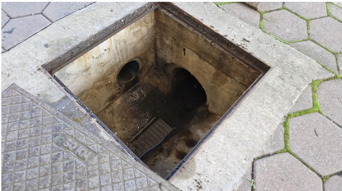
Slika 3. Postojeće revizijsko okon ROp1 na platou ispred upravne zgrade NP
