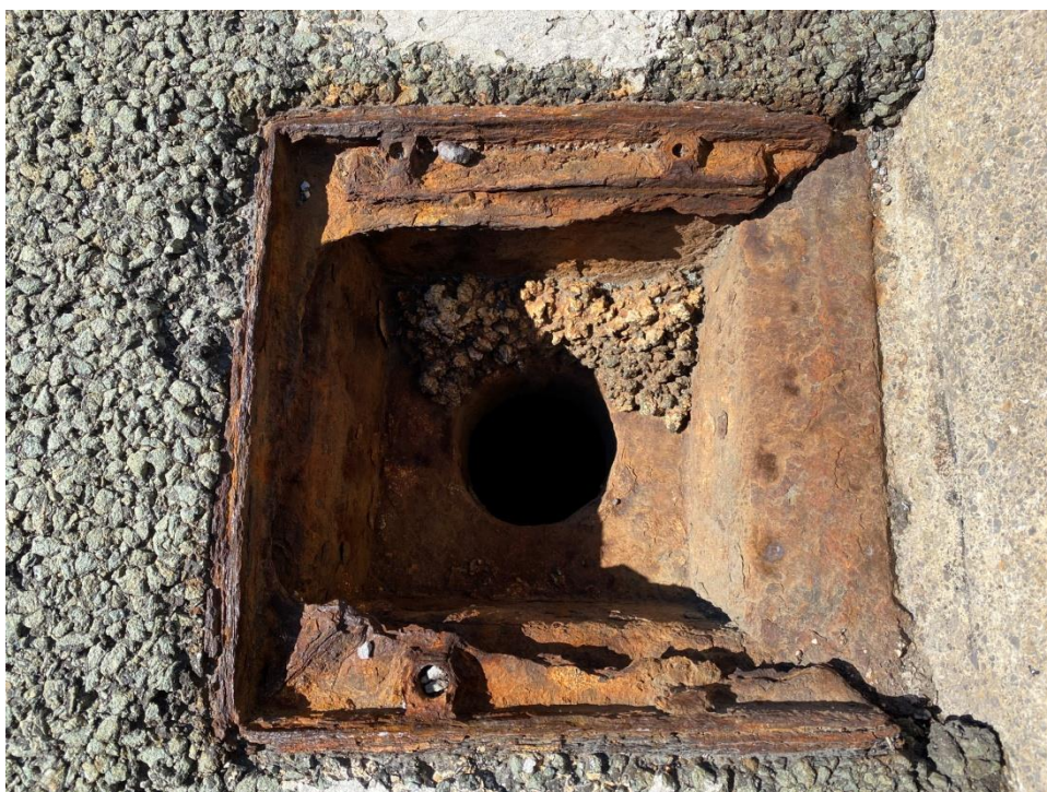
Slika 3: Slivnik bez slivničke rešetke
