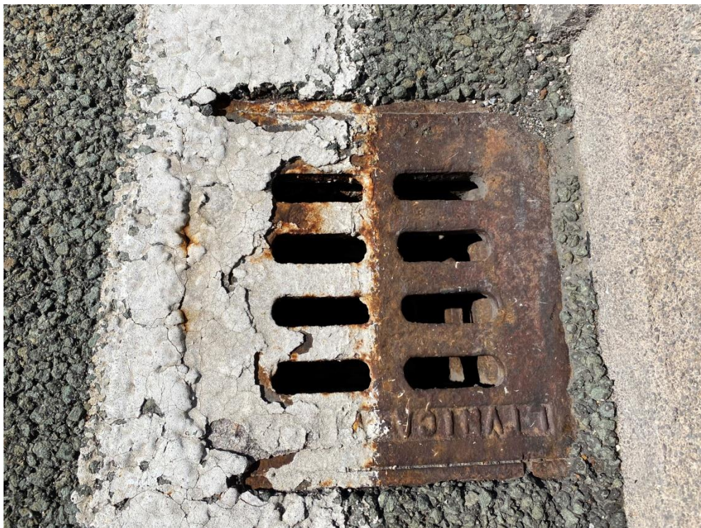
Slika 2: Tlocrtni prikaz slivnika
