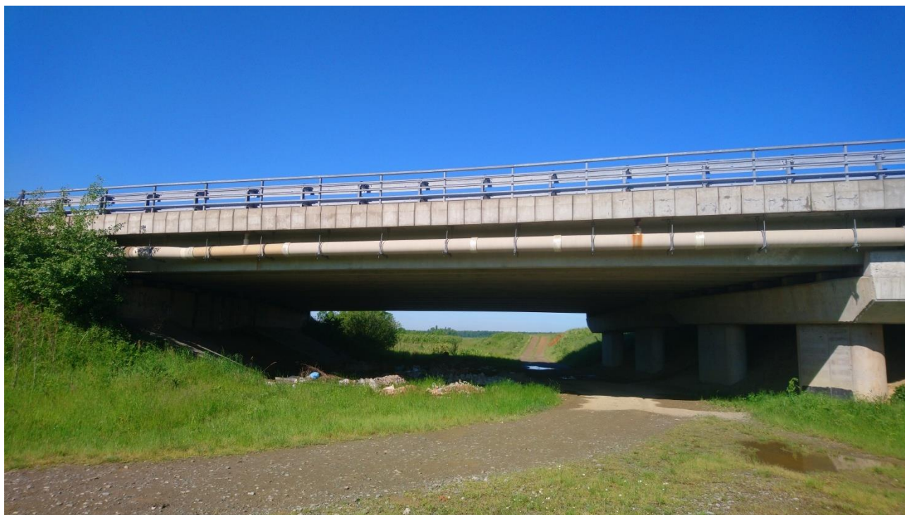
Slika 1. Most preko lateralnog kanala
