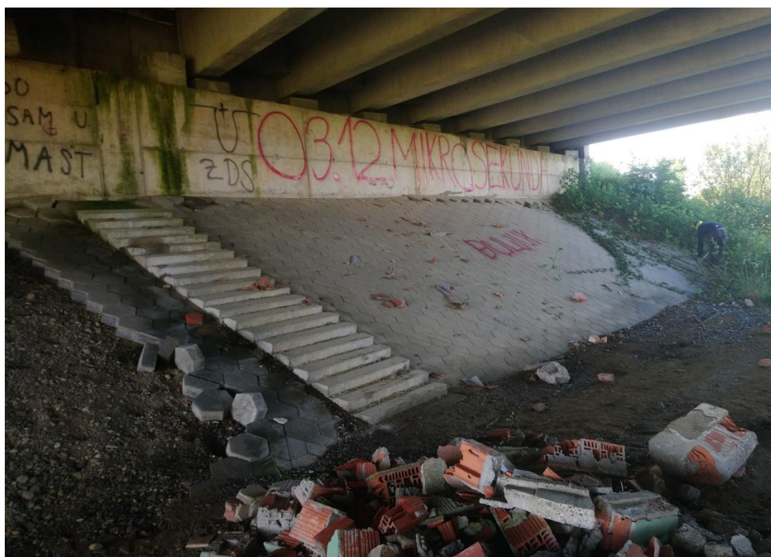
Slika 16. Desna strana obloge pokosa upornjaka
