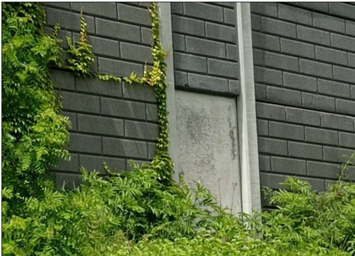
Slika 5. Oštećenje panela
