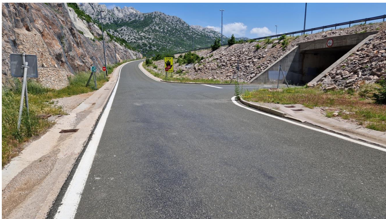
Slika 1. Pogled na T raskrižje prilazne ceste PUO Marune ( gledano u smjeru Zagreba )
