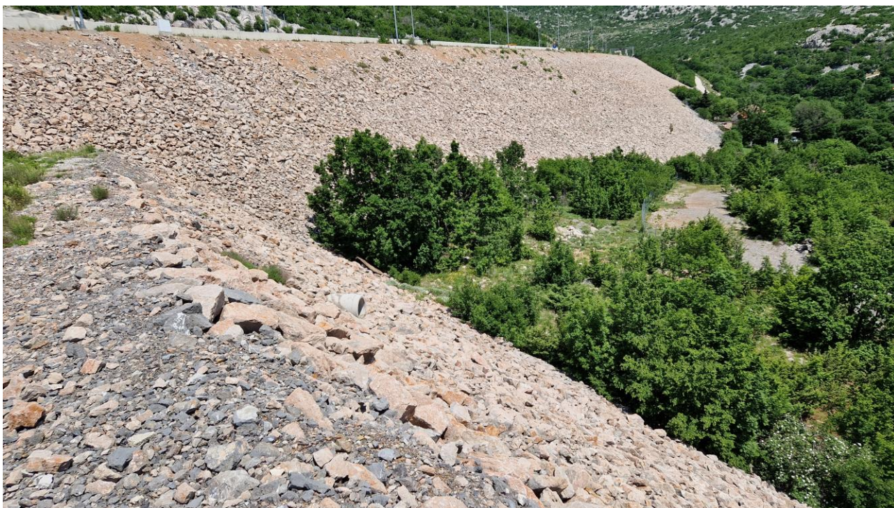
Slika 4. Ispust oborinske kanalizacije T raskrižja po pokosu nasipa nakon nadvožnjaka prilazne ceste
