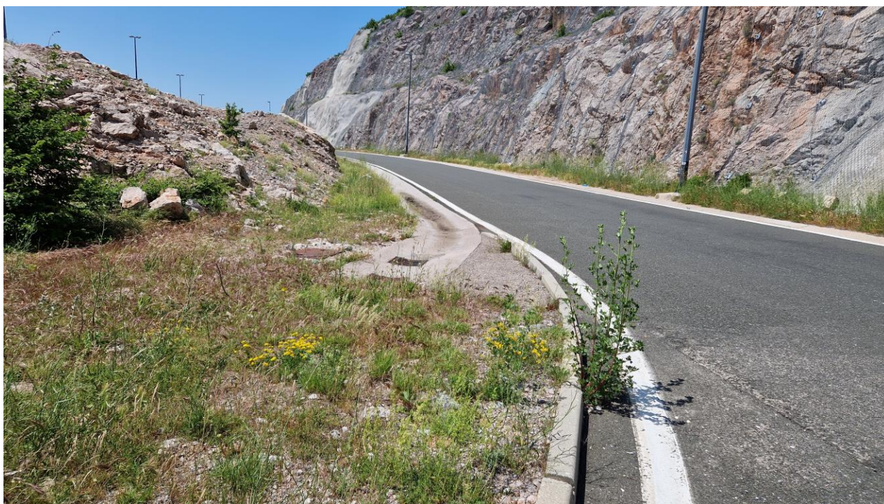
Slika 2. Pogled na postojeći slivnik i revizijsko okno T raskrižja ( gledano u smjeru Splita )
