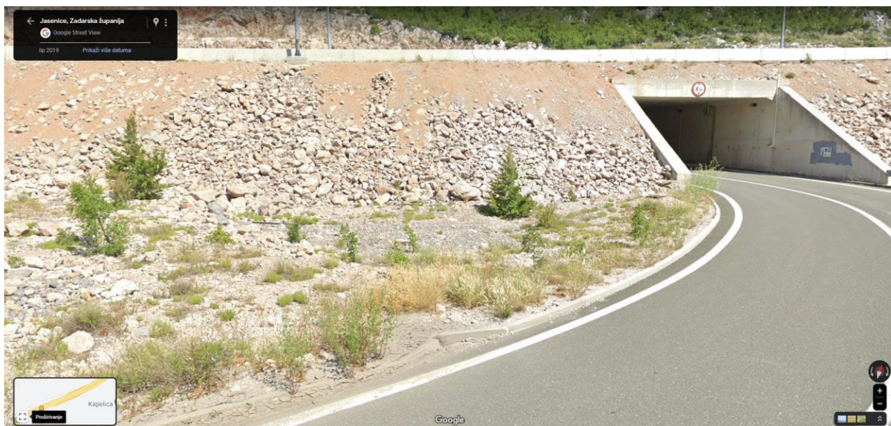
Slika 5. Prilazna cesta PUO Marune nakon nadvožnjaka i lokacija slivnika ( pogled u smjeru T raskrižja )
