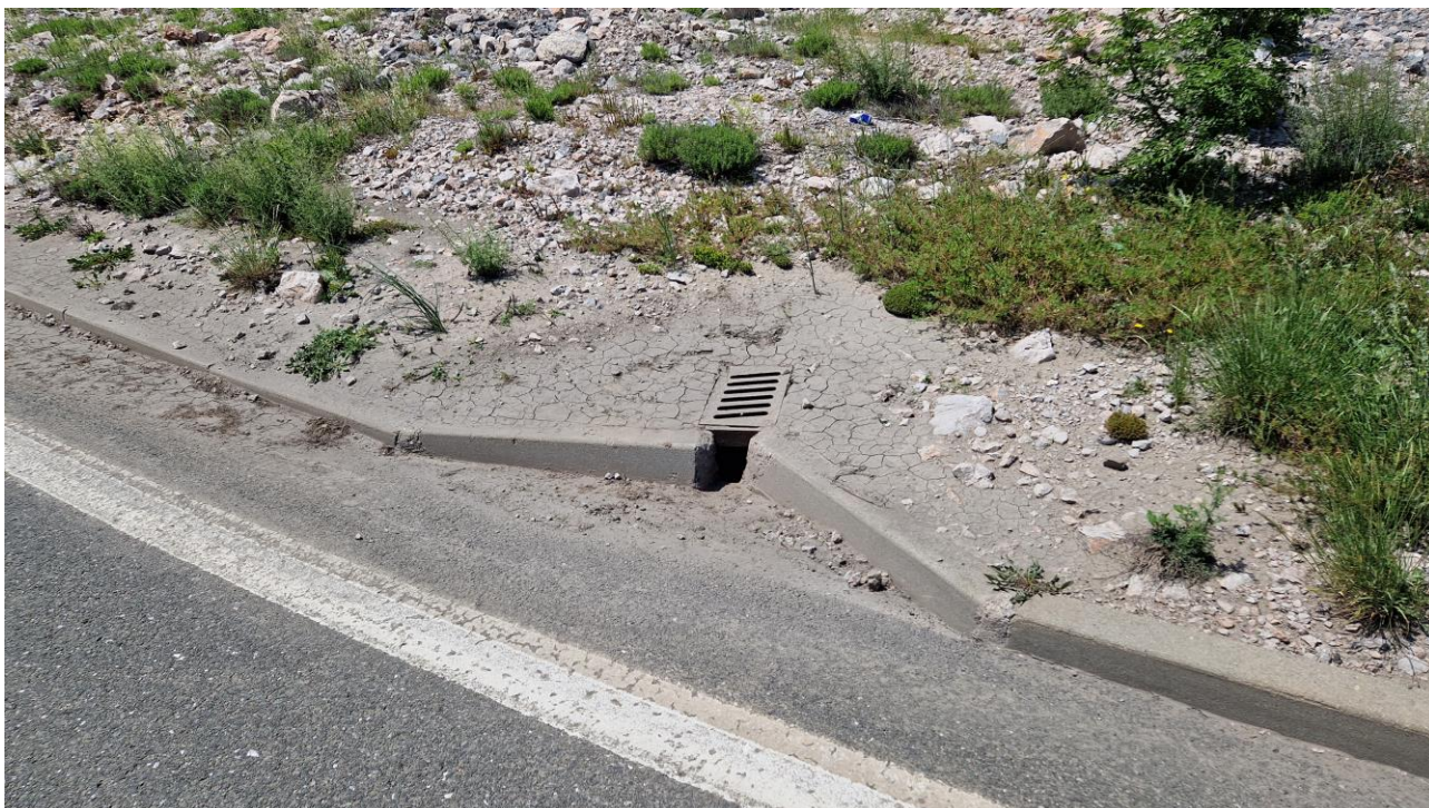
Slika 6. Postojeći slivnik nakon nadvožnjaka na prilaznoj cesti
