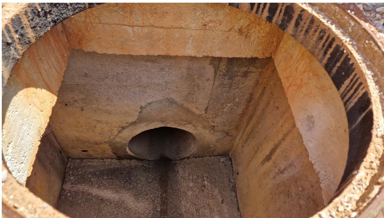
Slika 3. Postojeće revizijsko okno oborinske kanalizacije u T raskrižju prije podvožnjaka
