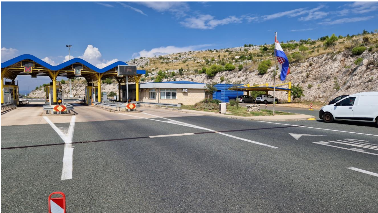
Slika 1. Pogled na kanal linijske odvodnje ( izlazna strana NP, pogled u smjeru AC )
