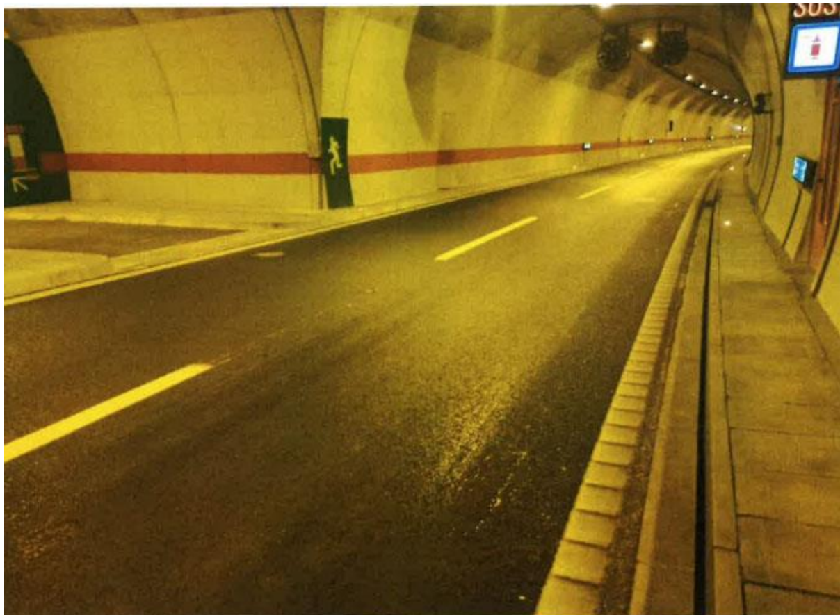
Slika 4. Desna cijev ( gledano u smjeru Dubrovnika ) - Poprečni spoj 2 – pogled na linijski kanal
