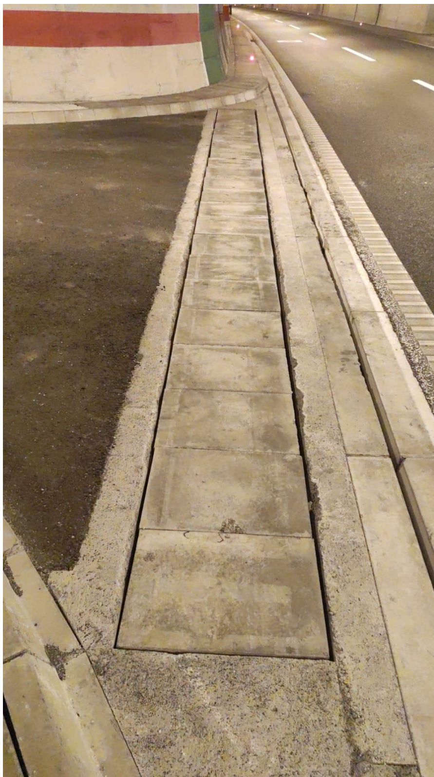
Slika 3. Desna cijev (gledano u smjeru Dubrovnika) - Poprečni spoj 1 – pogled na linijski kanal
