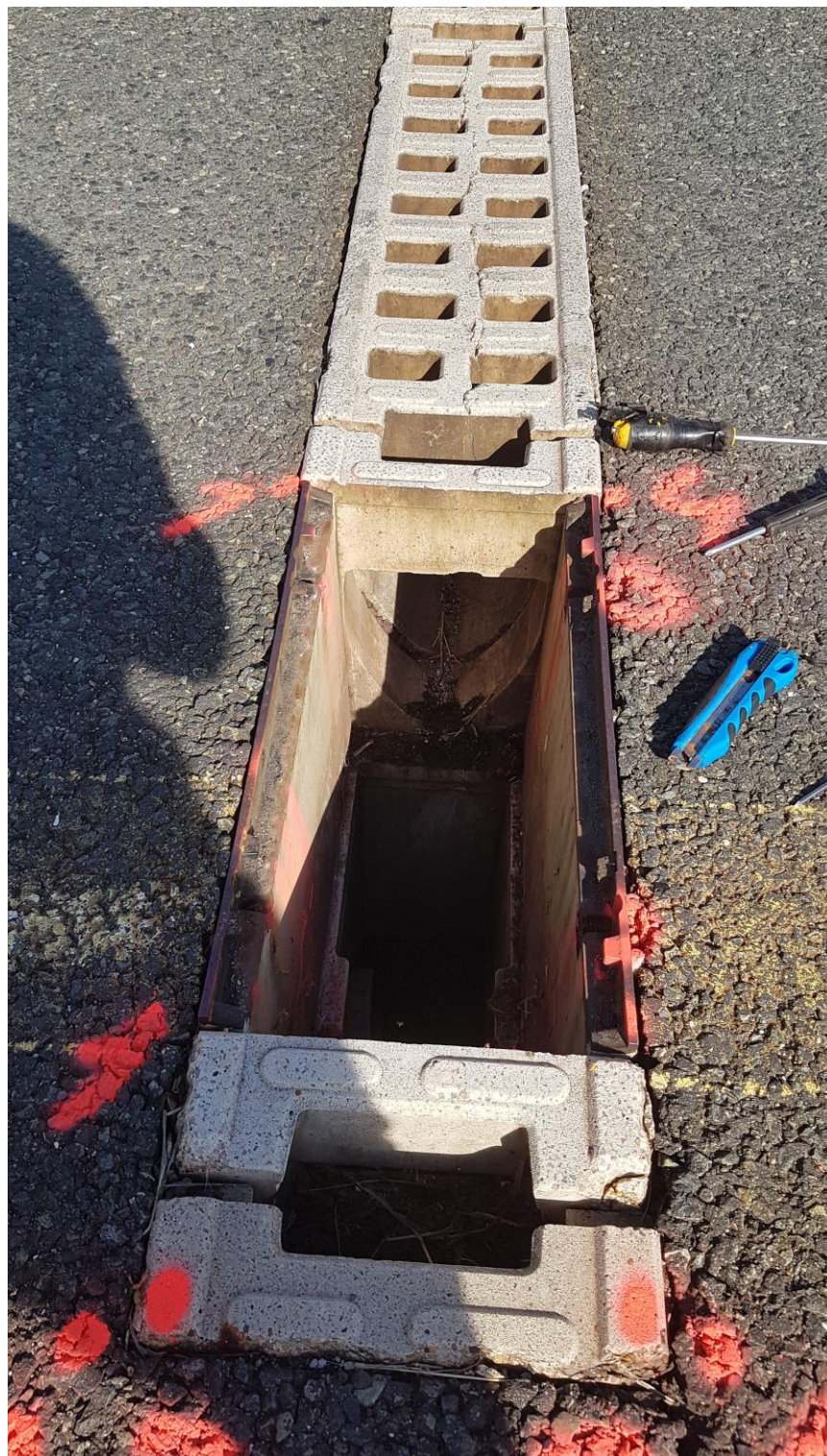
Slika 4. Revizija u stazi 7 ( izlazna staza ČCP, smjer Dubrovnik )
