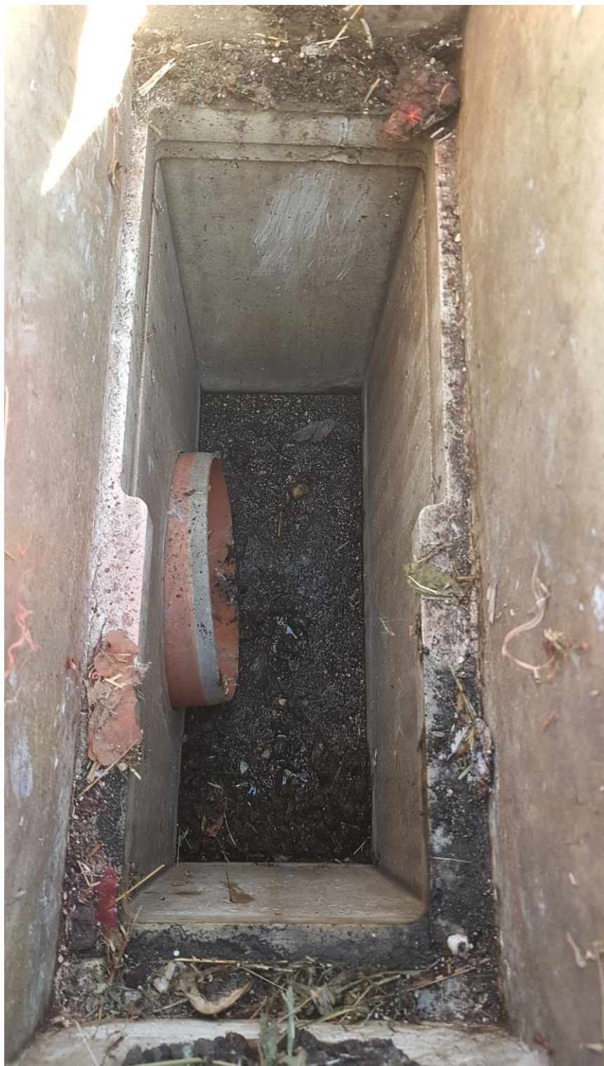
Slika 5. Revizija i ispust iz revizije u oborinsku kanalizaciju u stazi 7 ( izlazna staza ČCP, smjer Dubrovnik )
