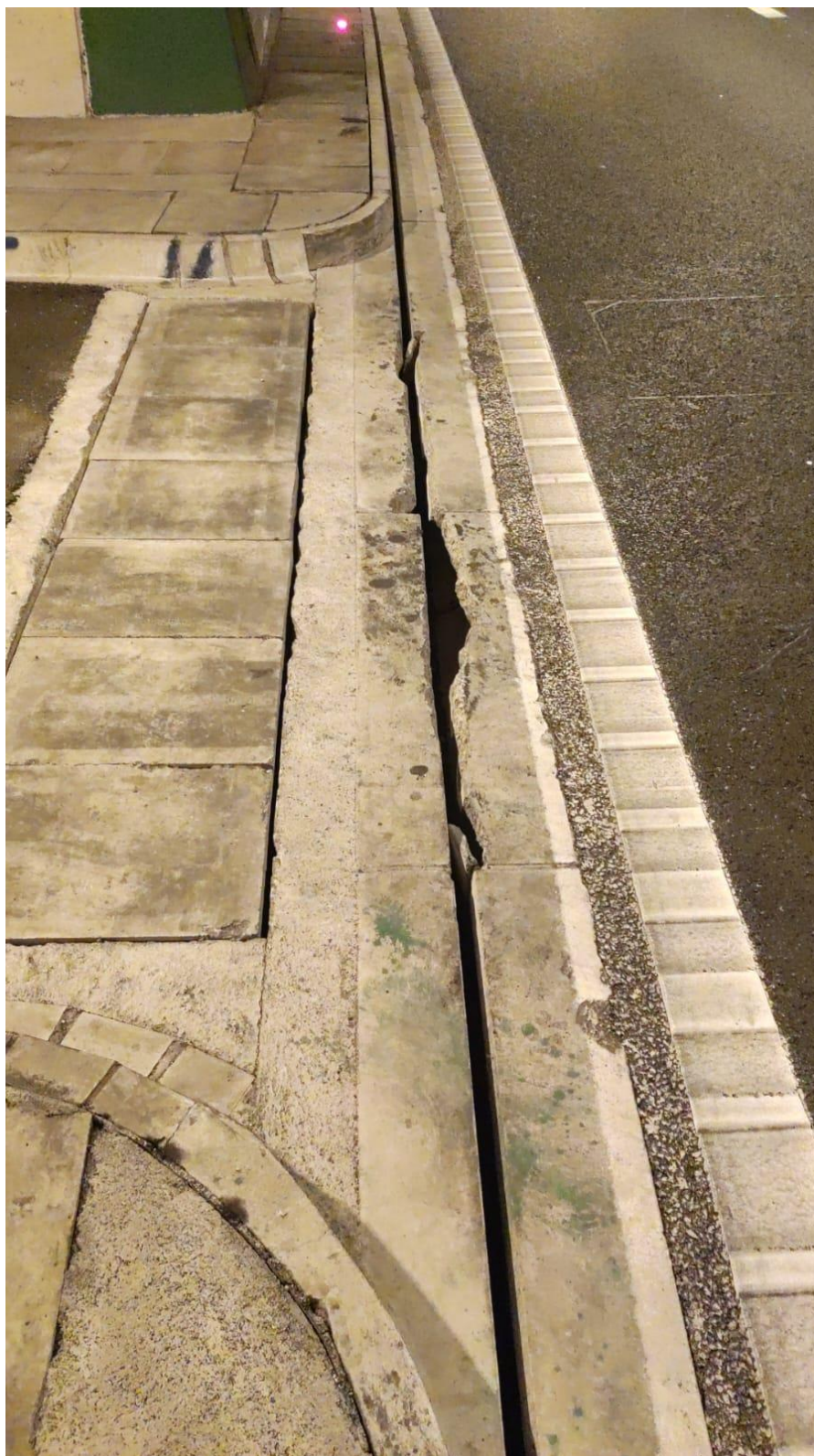
Slika 5. Desna cijev ( gledano u smjeru Dubrovnika ) - Poprečni spoj 2 – pogled na linijski kanal
