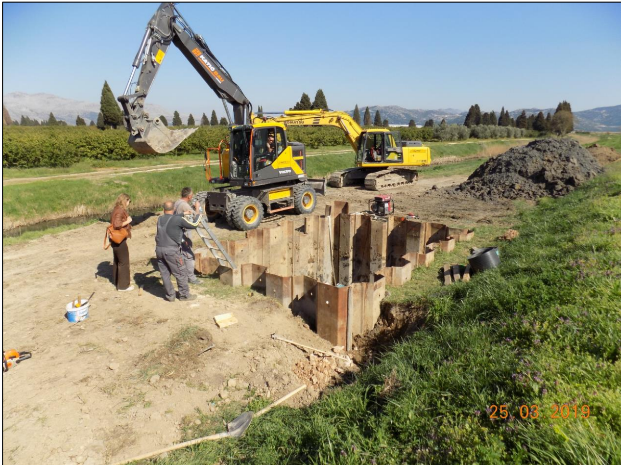
Slika 2: Zaštita građevne jame čeličnim žmurjem – primjer iz prakse
