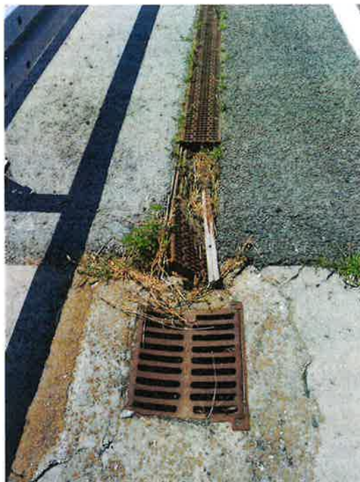
Slika 1. Službeni prolaz SP_1 – početak linijskog kanala – izljev u postojeći slivnik SLp1 ( u smjeru Čvora Đakovo )
