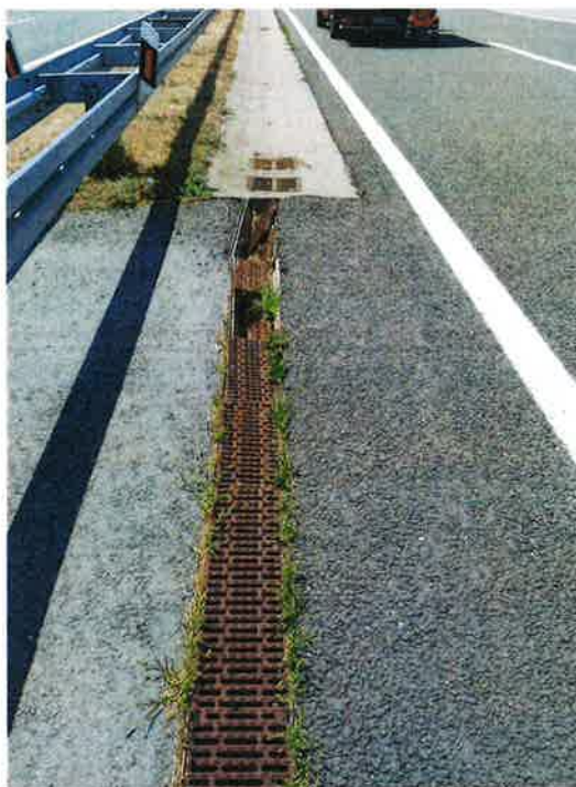
Slika 3. Službeni prolaz SP_1 –kraj linijskog kanala - postojeći slivnik SLp2 ( u smjeru Čvora Đakovo )
