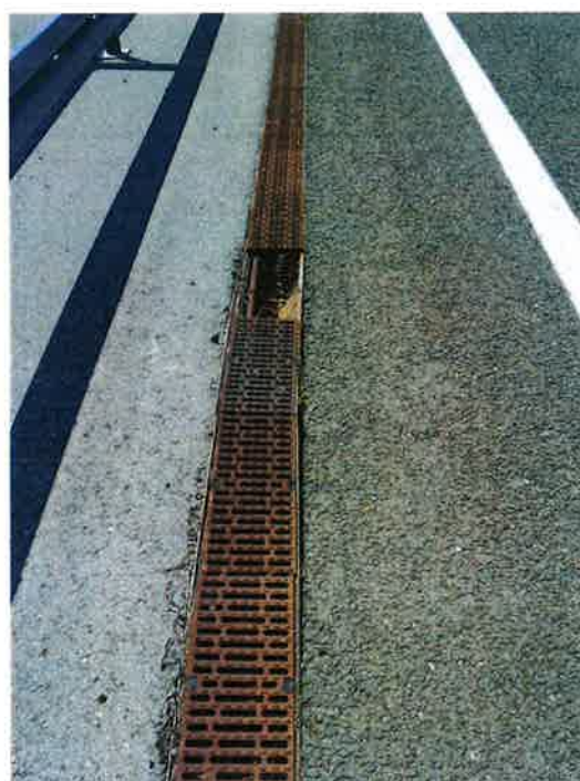
Slika 2. Službeni prolaz SP_1 – pogled na linijski kanal ( u smjeru Čvora Đakovo )
