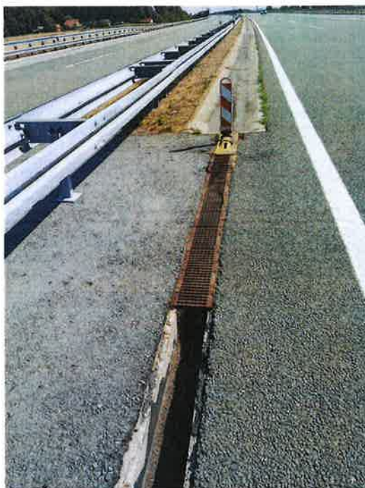
Slika 1. Službeni prolaz SP_3 – početak linijskog kanala ( gledano u smjeru Čvora Čepin )
