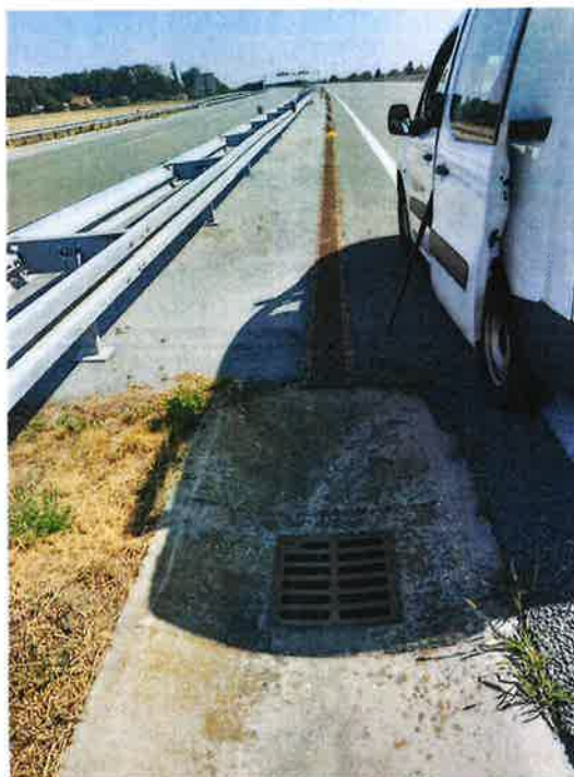
Slika 3. Službeni prolaz SP_3 –kraj linijskog kanala - postojeći slivnik SLp ( gledano u smjeru Čvora Čepin )
