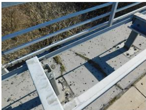
Slika 5_Propust u km 77+130, vanjska staza. Poprečne
