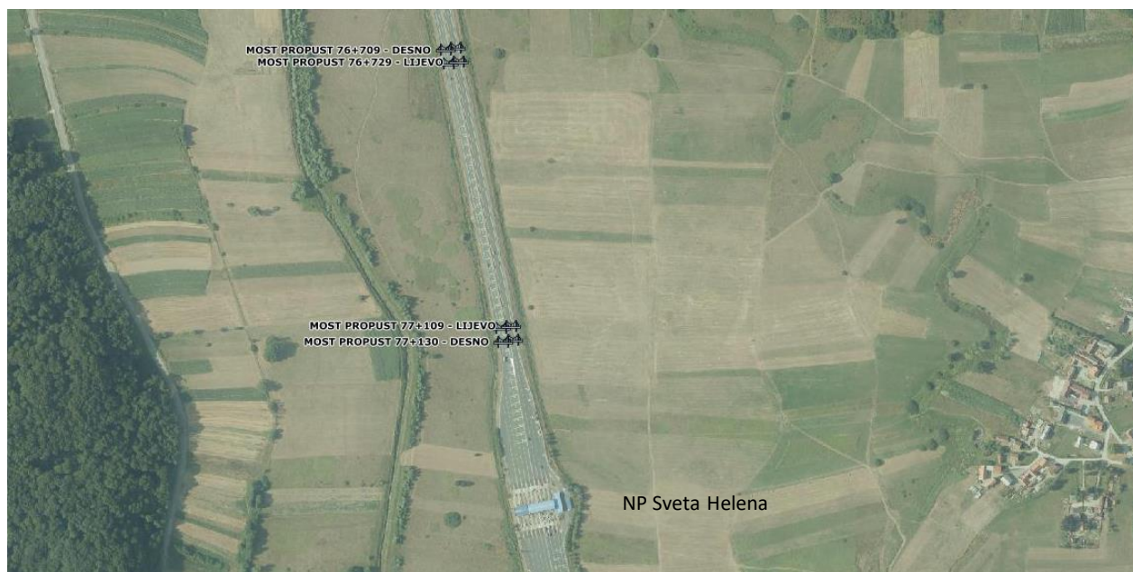
Slika 1_Propust 77+130 – lijevo i Propust 76+729 – lijevo na autocesti A4
