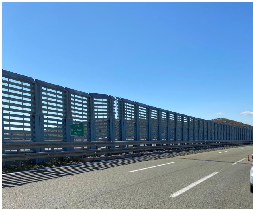
Slika 1: Vijadukt Mali Svib
