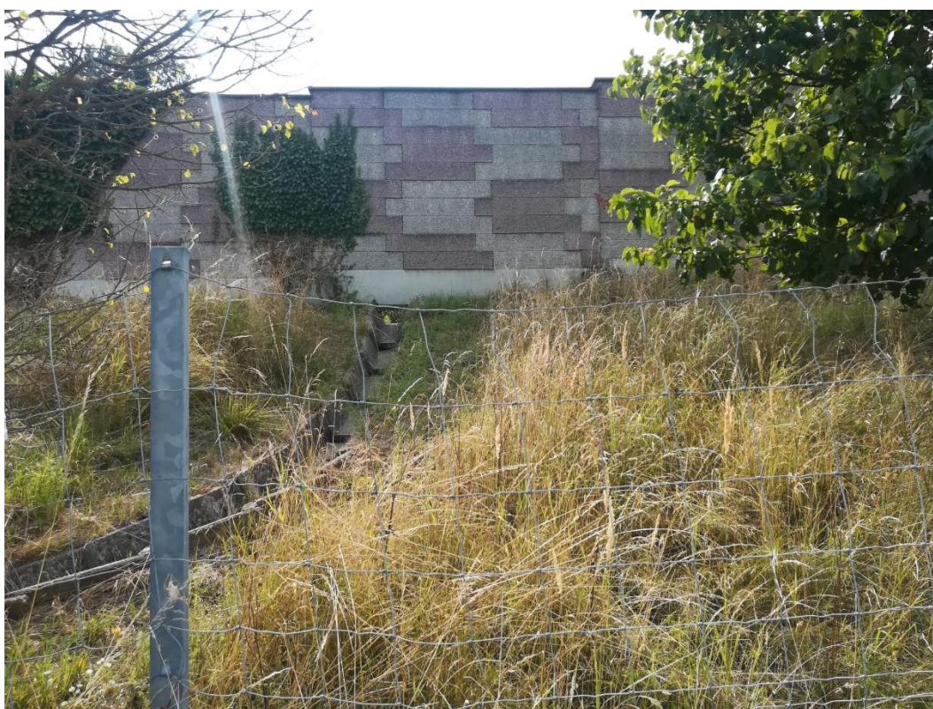
Slika 2 Pregled predmetne lokacije - Kanalica za prihvat voda s autoceste
