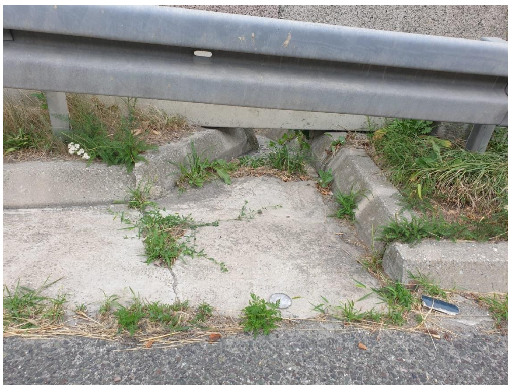
Slika 3. Pregled predmetne lokacije - Ispust oborinskih voda s autoceste
