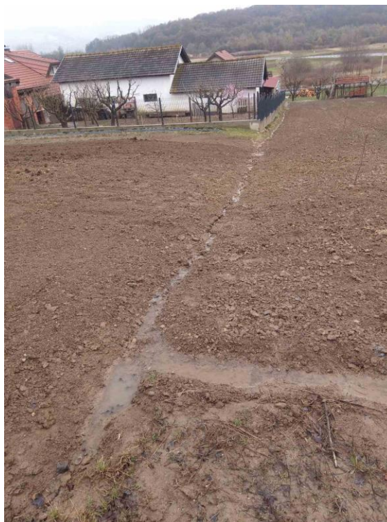
Slika 7. Pregled predmetne lokacije - Poplavljena parcela uz AC uslijed otjecanja oborinske vode s AC
