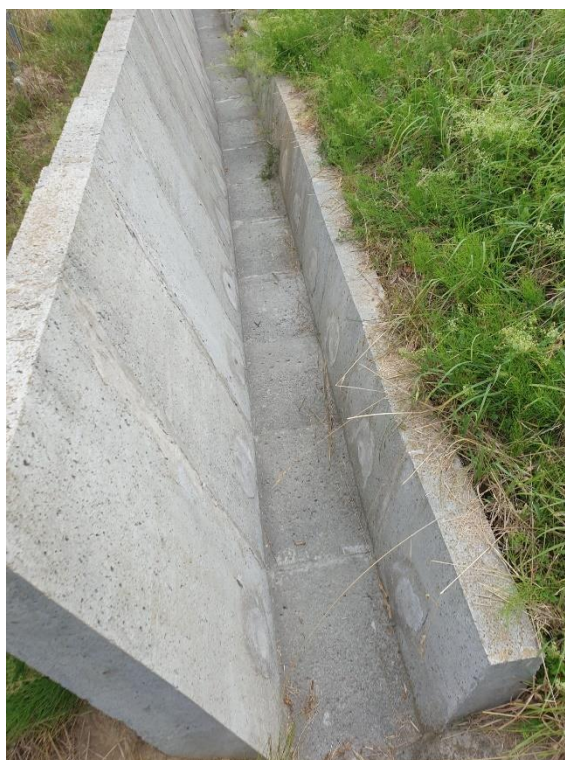
Slika 5. Pregled predmetne lokacije - Postojeći betonski kanal
