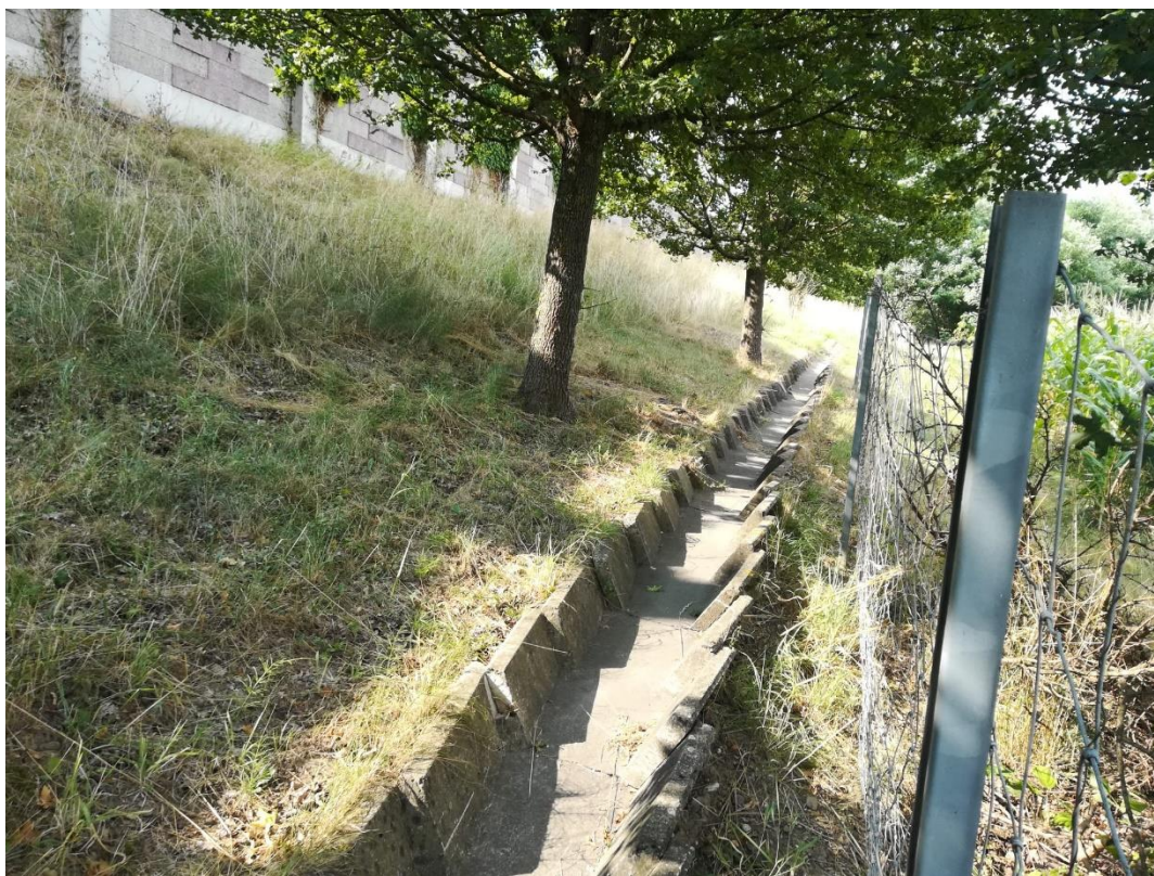
Slika 1 Pregled predmetne lokacije – postojeći trapezni kanal
