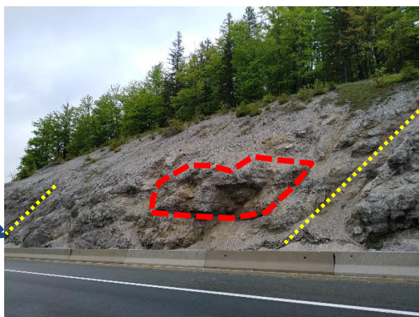
Prikaz nestabilnosti formiranih u naslagama dolomita u sklopu predmetnog pokosa predmetnog usjeka; nestabilni blokovi i blokovi u prevjesu (crvena boja), pukotine (žuta boja), stvaranje klina (plava boja, slika lijevo)
