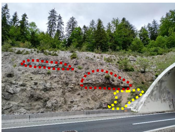
Prikaz nestabilnosti formiranih u naslagama dolomita u sklopu predmetne kosine; ispiranje i osipavanje (žuta boja), blokovi u prevjesu (crvena boja) predmetnog usjeka.
