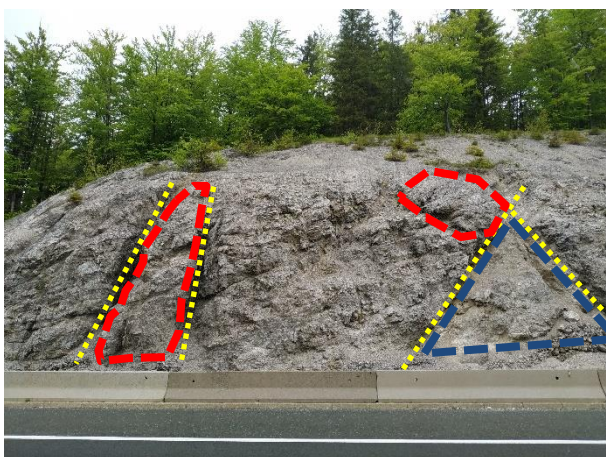
Prikaz nestabilnosti formiranih u naslagama dolomita u sklopu predmetnog pokosa predmetnog usjeka; nestabilni blokovi i blokovi u prevjesu (crvena boja), pukotine (žuta boja), stvaranje klina (plava boja, slika lijevo)
