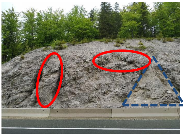
Prikaz nestabilnosti formiranih u naslagama dolomita u sklopu predmetnog pokosa predmetnog usjeka; nestabilni blokovi i blokovi u prevjesu (crvena boja), ispiranje i osipavanje (žuta boja), stvaranje klina (plava boja, slika desno)
