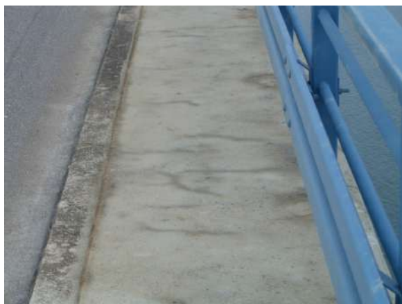
poprečne pukotine
