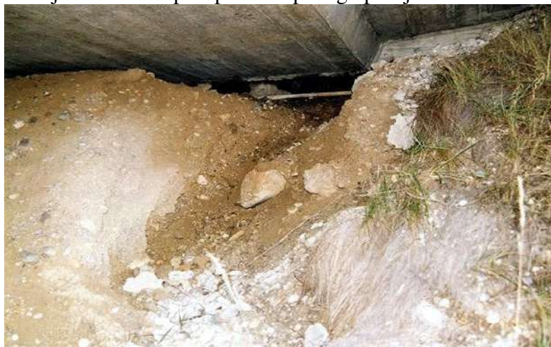
Erozija kosine nasipa ispred zatrpanog upornjaka
