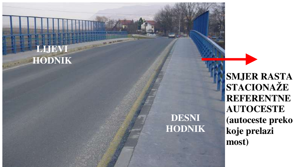
Pogled na površinu kolnika mosta preko trase autoceste i definicija smjera lijevo i desno
