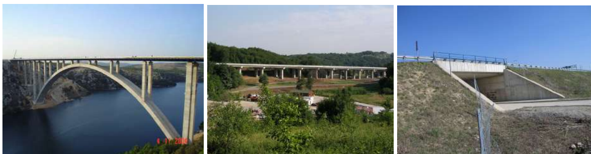
Mostovi u trasi autoceste: most; vijadukt; podvožnjak
