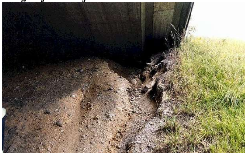
Erozija kosine nasipa ispred zatrpanog upornjaka
