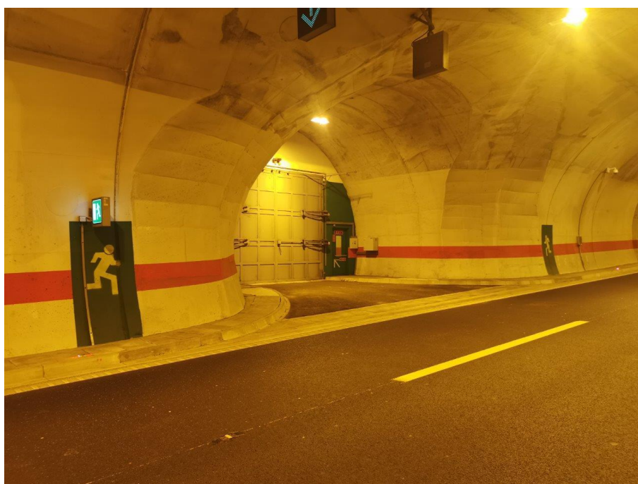
Slika 2. Desna cijev ( gledano u smjeru Dubrovnika ) - Poprečni spoj 1 – pogled na linijski kanal
