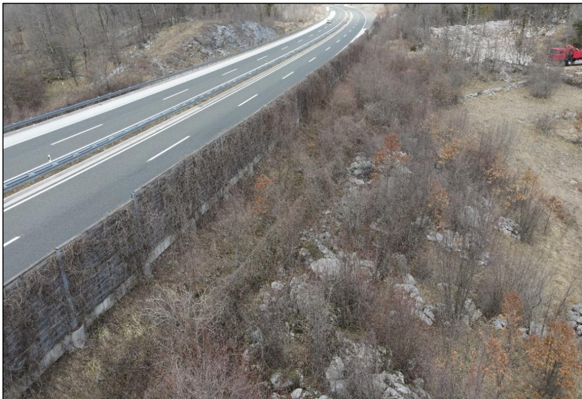
Slika 9. km 8+700.00 – 8+900.00 – zid za zaštitu od buke obrastao bršljanom
