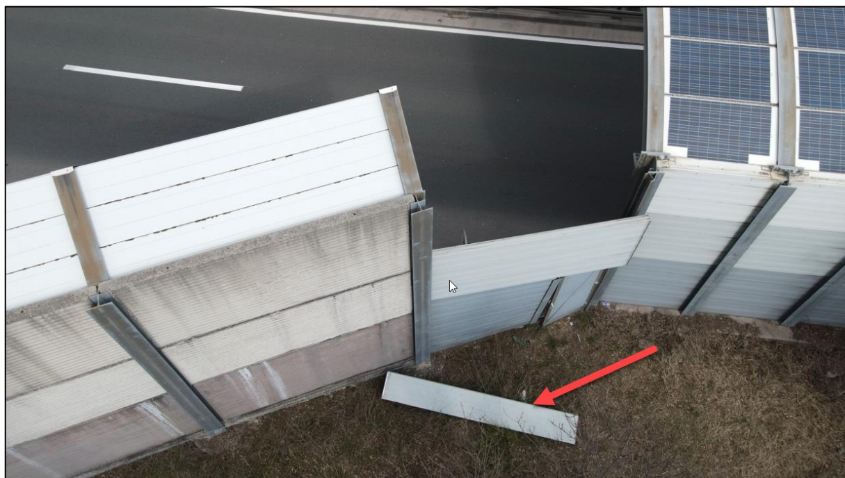
Slika 25. km 25+000.00 – odvojeni aluminijski panel
