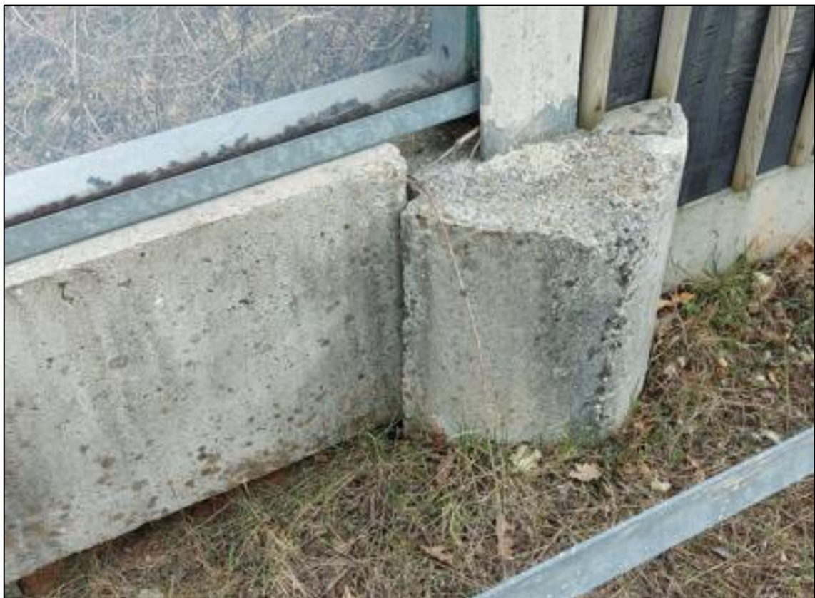
Slika 14. km 9+000.00 - 9+500.00 - odvajanje naglavnih greda i glava pilota
