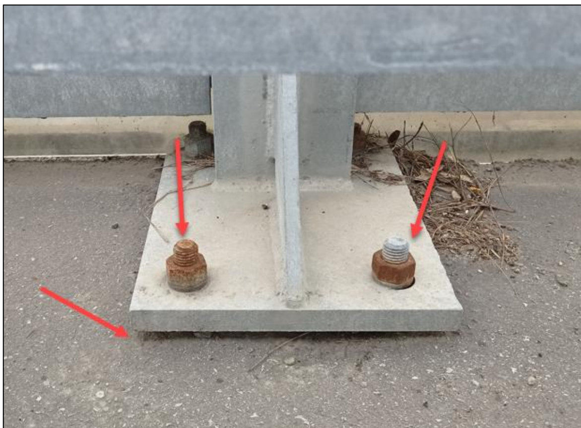
Slika 4. Odvajanje HEA profila / hrđa na vijku i matici – smjer BiH
