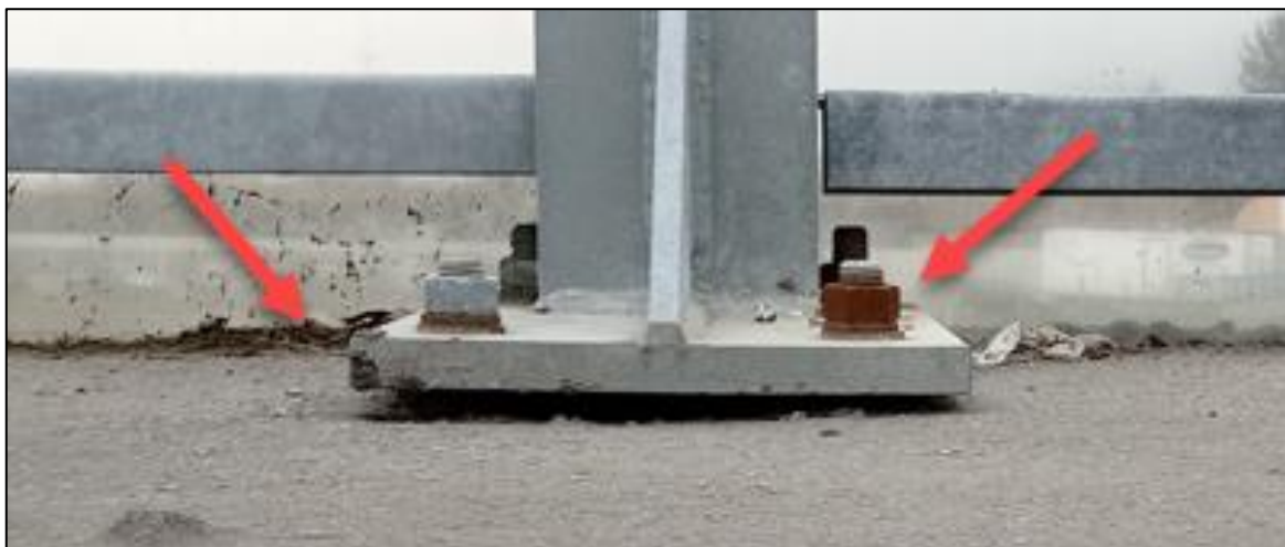
Slika 3. Odvajanje HEA profila / hrđa na vijku i matici – smjer Beli Manastir
