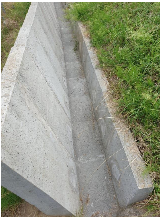
Slika 5. Pregled predmetne lokacije - Postojeći betonski kanal
