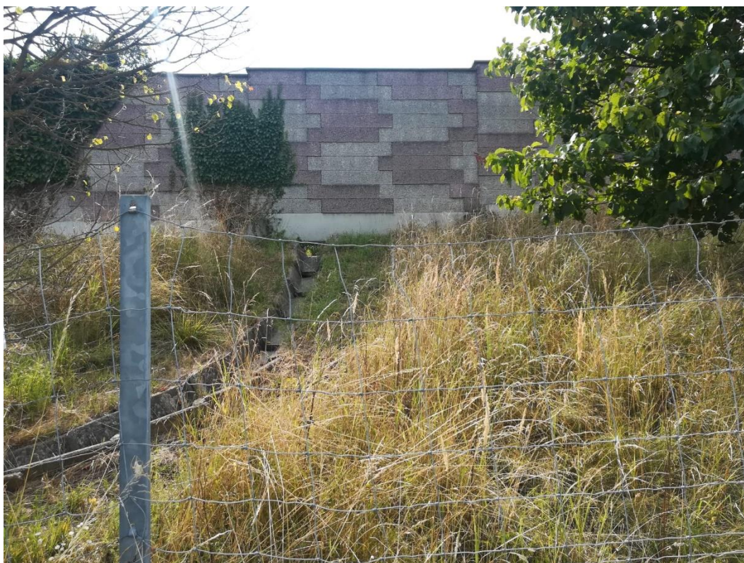
Slika 2 Pregled predmetne lokacije - Kanalica za prihvat voda s autoceste
