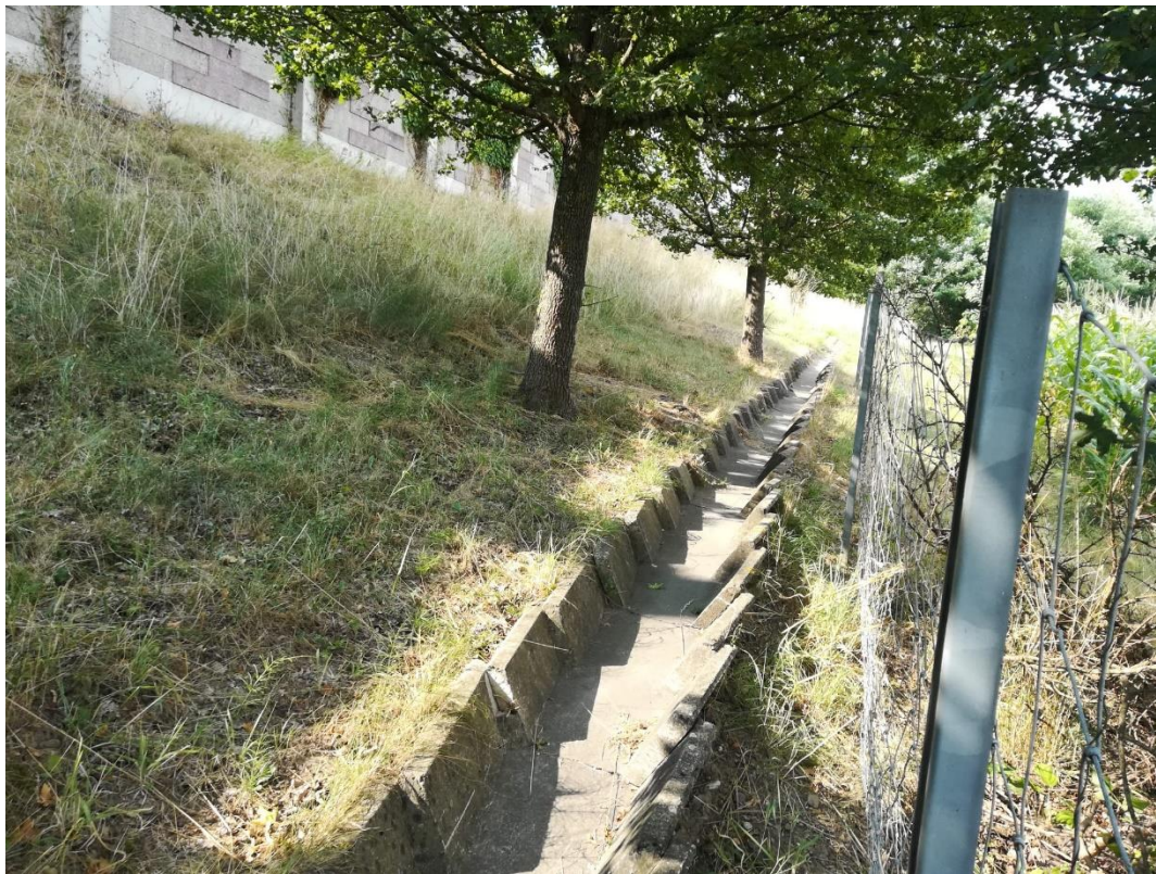
Slika 1 Pregled predmetne lokacije – postojeći trapezni kanal
