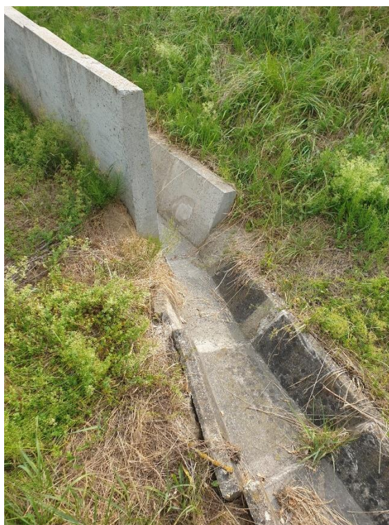
Slika 4. Pregled predmetne lokacije - Spoj prethodno saniranog kanala i trapezne kanalice
